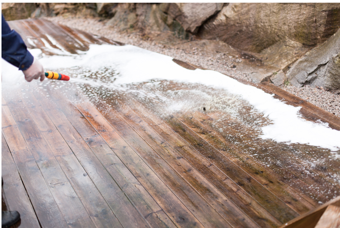
SÅPE OG VANN: Det gjelder å vaske grundig og skylle enda grundigere før terrassen beises, oljes eller behandles på annet vis.
