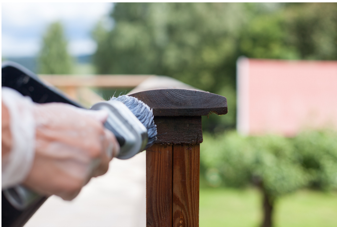
NATURLIG GRÅTT: Silisiumbehandling kan brukes på trykkimpregnert tre, lerk, furu, gran, eik og teak. Behandlingen gjør at treverket raskt får en jevn, sølvgrå farge. Overflaten blir hard og jevn og er behagelig å ta på og gå barbeint på.
