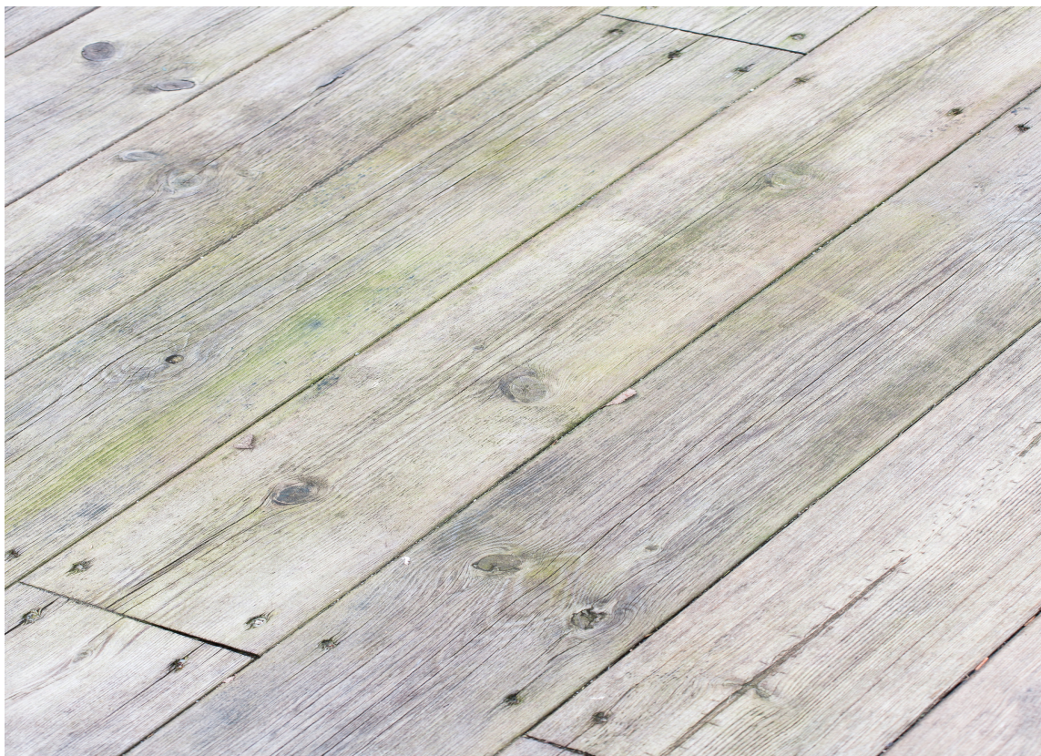
VÆRBITT: Naturen setter sine spor. Også på terrassen. Derfor trenger den jevnlig behandling.
