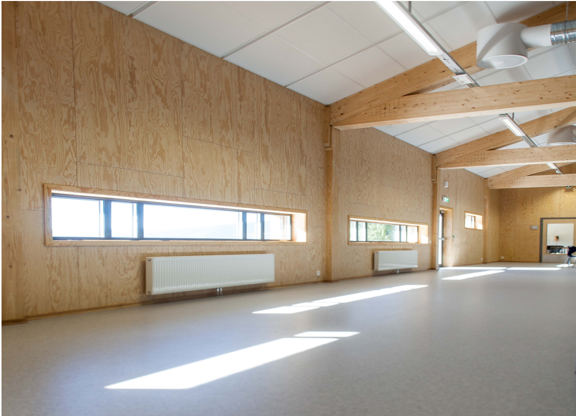
TRE OG VINYL: Galleriet over gymsalen er romslig og luftig, på gulvet er det lagt et 2 mm homogent vinylgulv, det samme som i trapper og klasserom.
