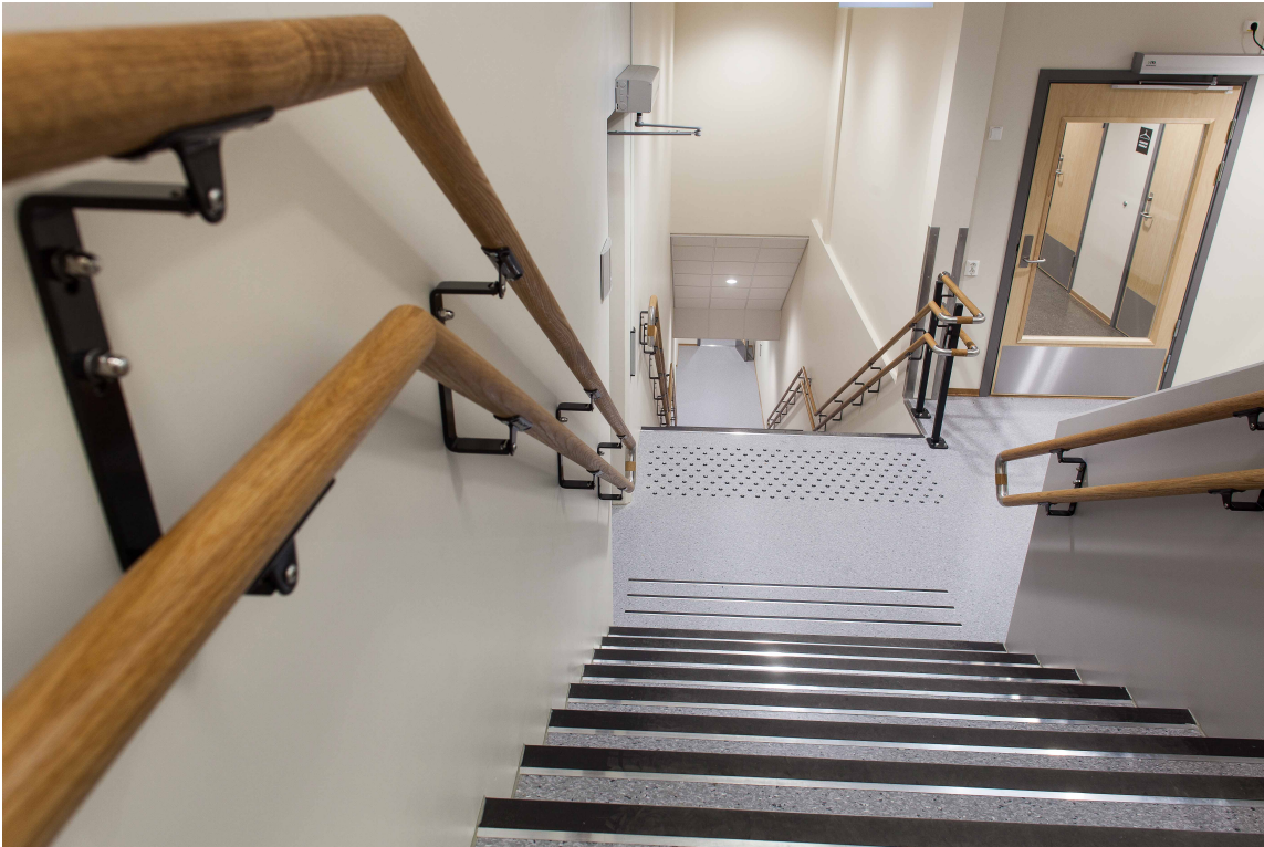
HELHET: En trappegang med belegg i trappa. Veggene er sandsparklet og malt. Den lyse veggfargen og det gråmelerte vinylbelegget er gjennomgående i bygget.
