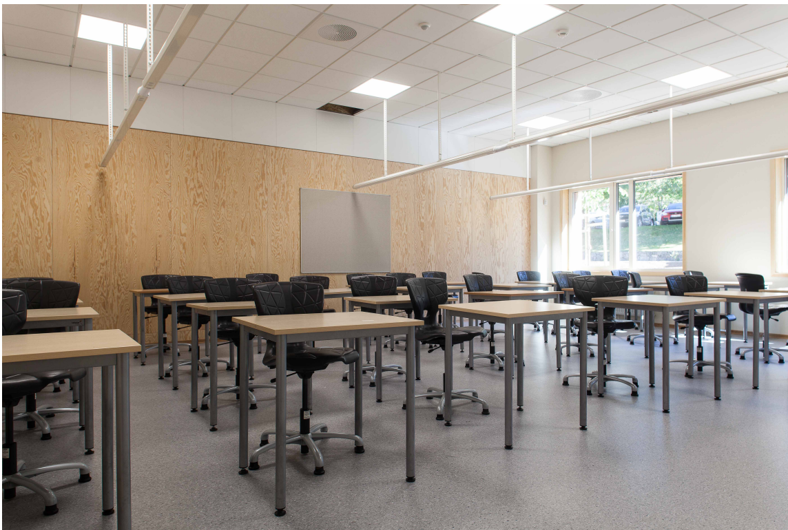
LAKKERT: De nye klasserommene har en fondvegg av finerplater. Platene er påført 3 strøk matt klarlakk.
