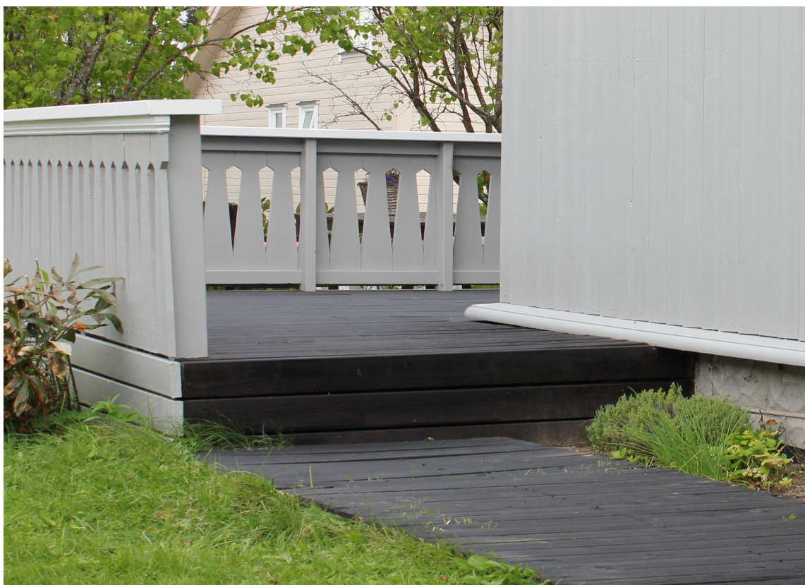
BEIS: Terrassebeis eller terrasseolje trekker inn i treverket. Med re-beising hvert eller annethvert år holder det seg fint lenge. (Foto: Bjørg Owren/ifi.no)
