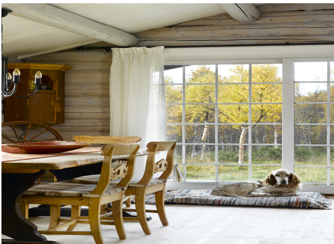
LYSNEDE VEGGER Hyttas tømmervegger var mørknet betraktelig etter mange årtier uten beskyttelse mot UV-stråler. For å få tilbake tømmerets opprinnelige utseende, ble det her brukt panellakk for å få det lysere.
