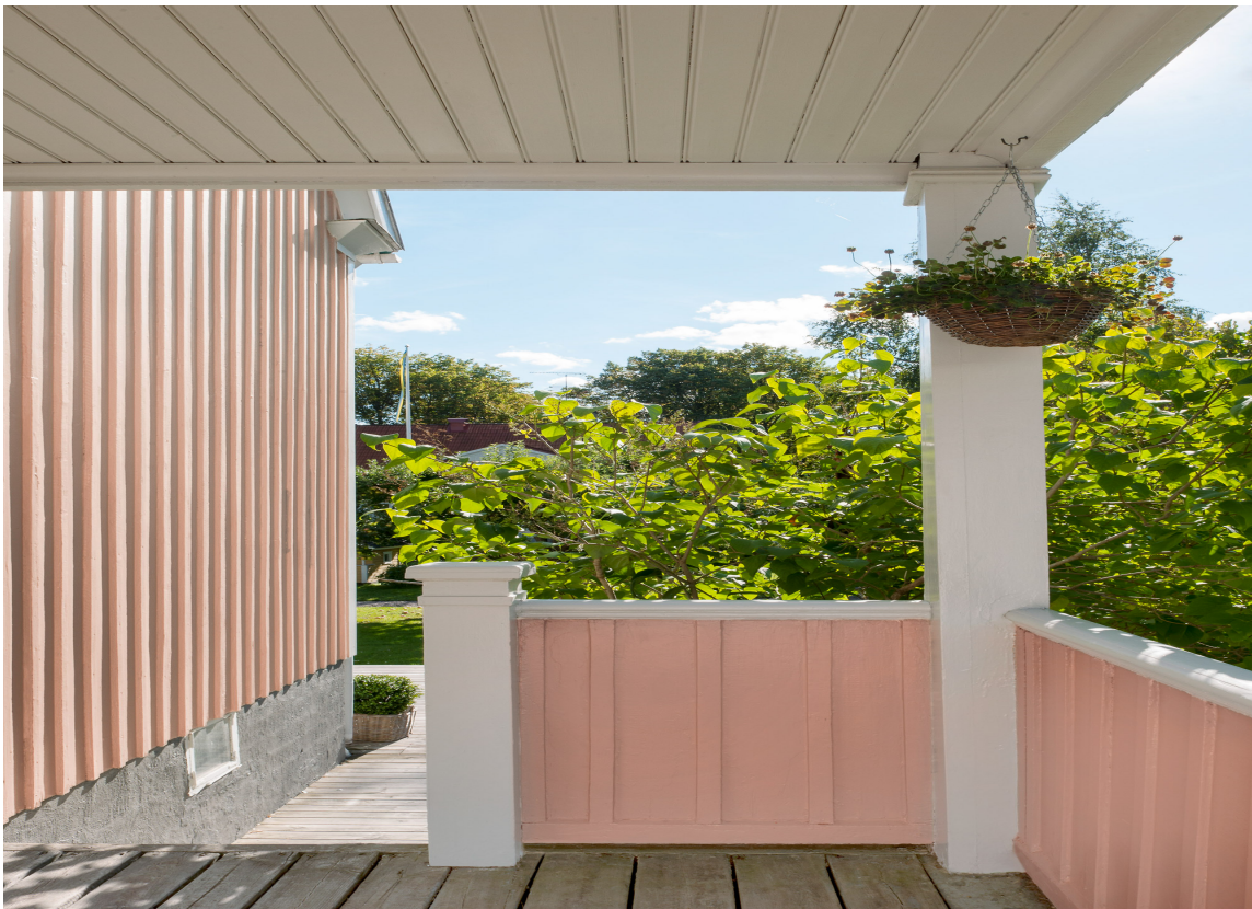
GRÅ MUR: Her er det valgt en grå mur som passer fint til den rosa fasaden.
