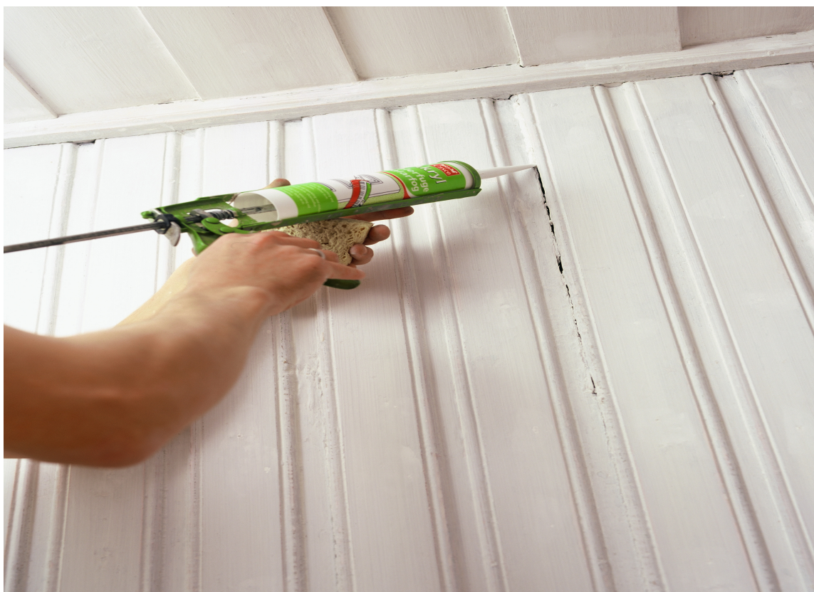
SPREKK: Når luftfuktigheten blir lav i rommet, trekker trepanelet seg sammen. Da kan det dannes sprekker mellom bordene. (Foto: Frode Larsen/ifi.no)
