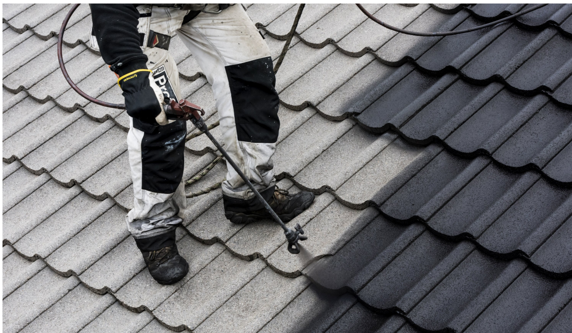
PÅFØRING: Med høytrykksprøyte kan et 150 kvadratmeter tak bli som nytt på to dager.
