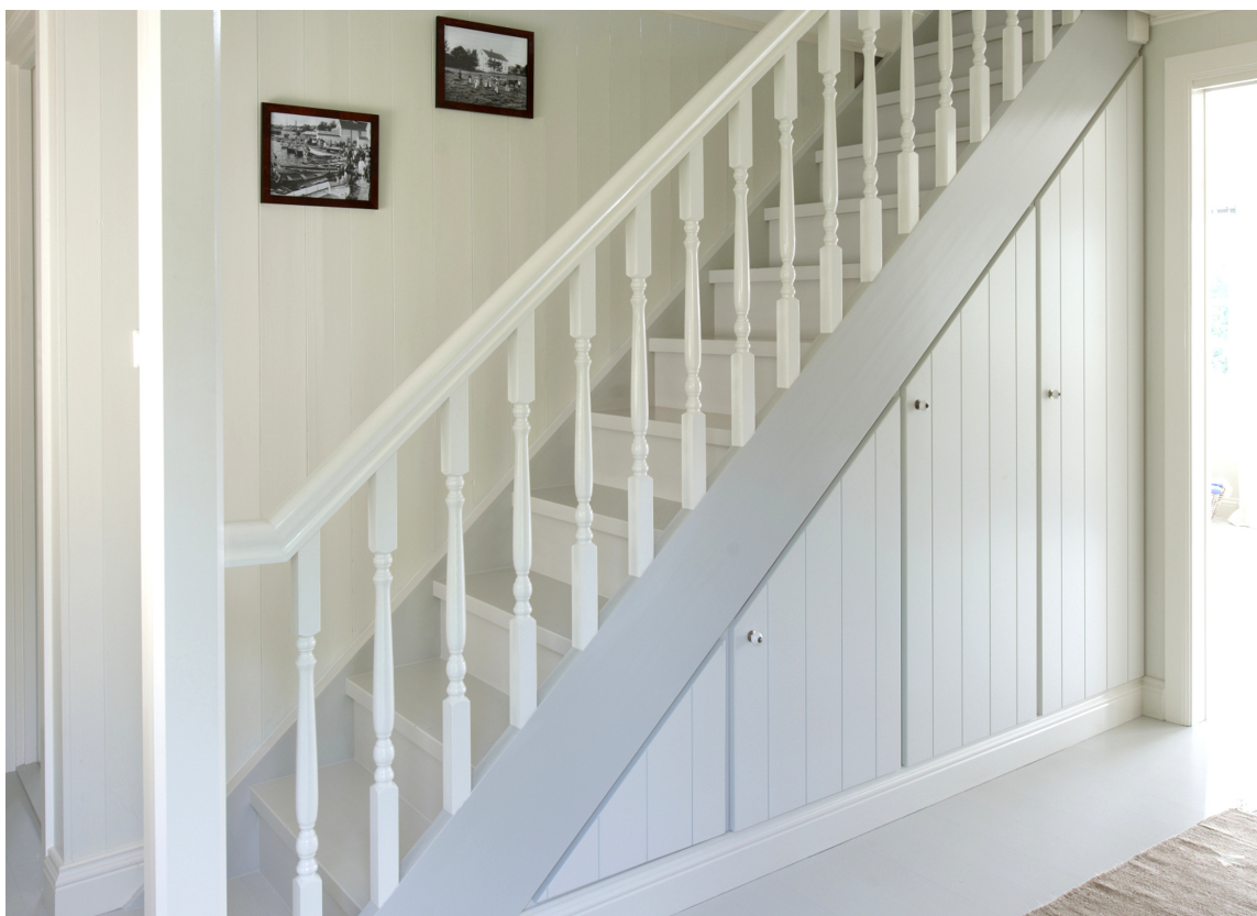
DISKRET: Fra åpent og rotete til skreddersydde skap, som er malt i trappens farger for ikke å stikke seg ut. Panelte dører, som ligner veggene, gjør at de glir enda mer inn i interiøret. (Foto: Espen Grønli/ifi.no)
