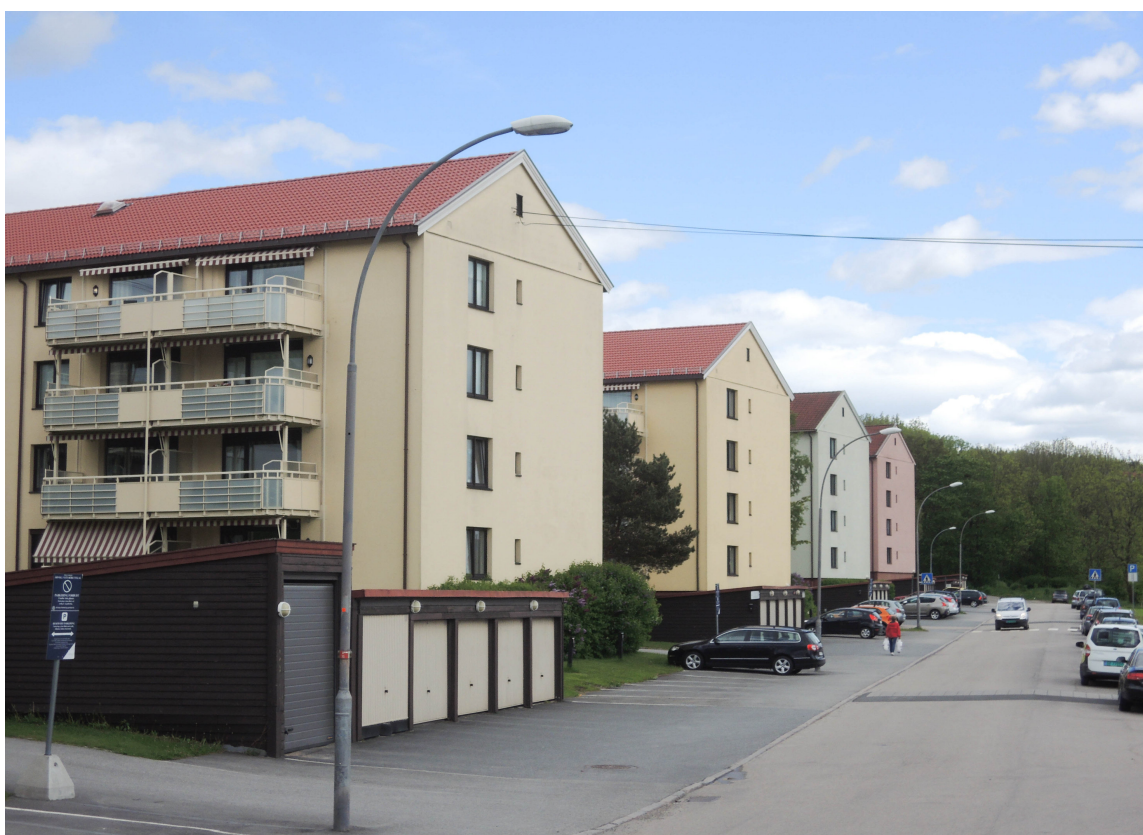
INVESTERING: Planmessig vedlikehold er god investering for alle typer bygg. (Foto: Chera Westman/ifi.no)
