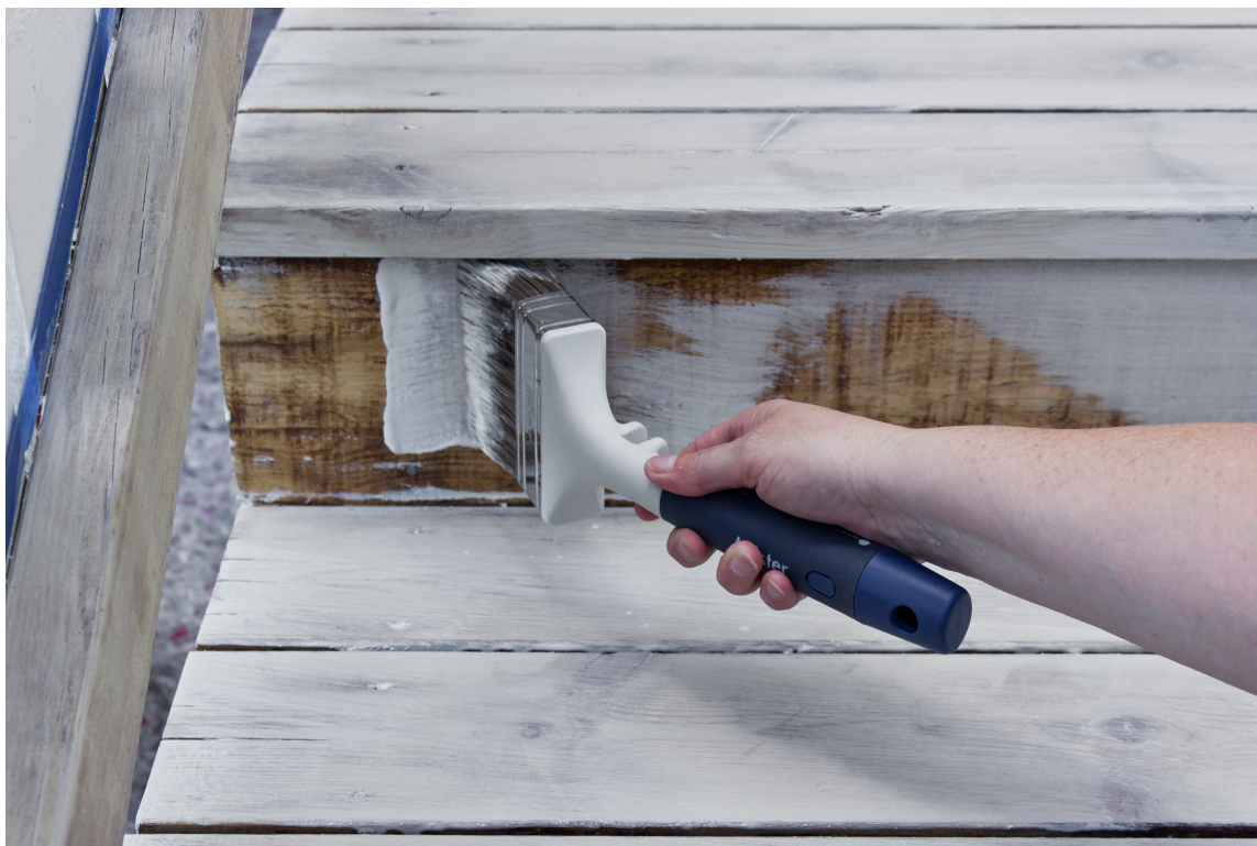
PENSELPÅFØRING: Til beising av rekkverk og opptrinn i trappen, brukes en flat, bred pensel. Det er viktig å arbeide i hele bordets lengde for å unngå skjolder.
