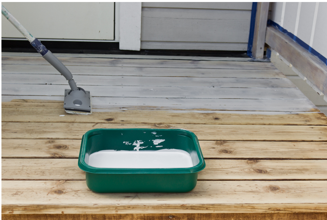
MALEPAD: Beisen påføres med en malepad som er montert på justerbart forlengerskaft. Paden gjør at beisen ikke spruter, og legges på i et jevnt strøk.
