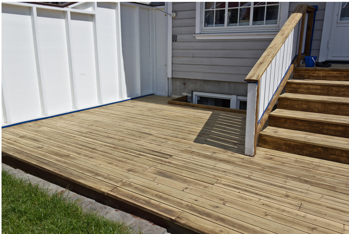
SLITT: Etter vask, rens og sliping er plattingen klar for ny behandling.
