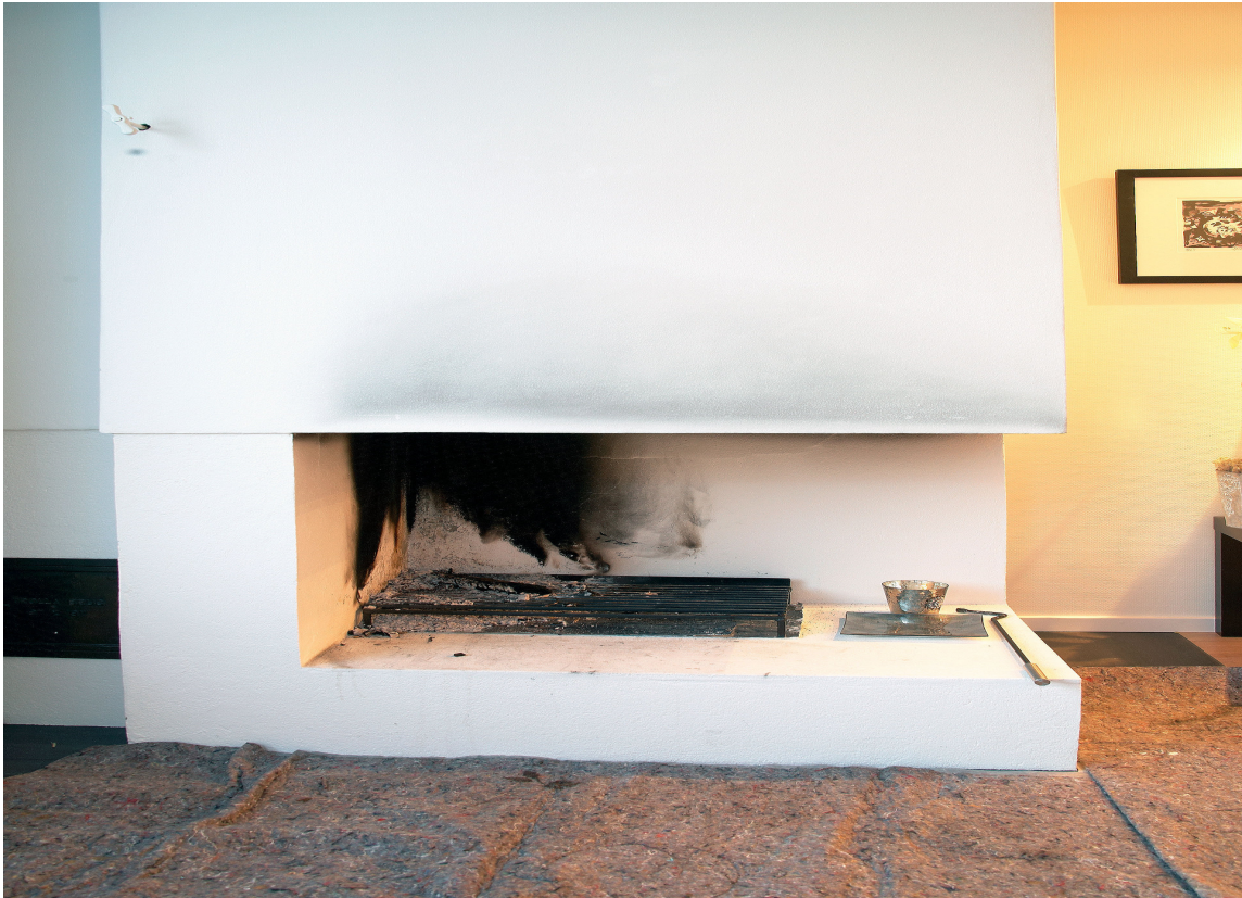
UHELL: Dårlig trekk eller bare glemte å åpne spjeldet... og den hvite peismuren ble grå. (Foto: Kristian Owren/ifi.no)
