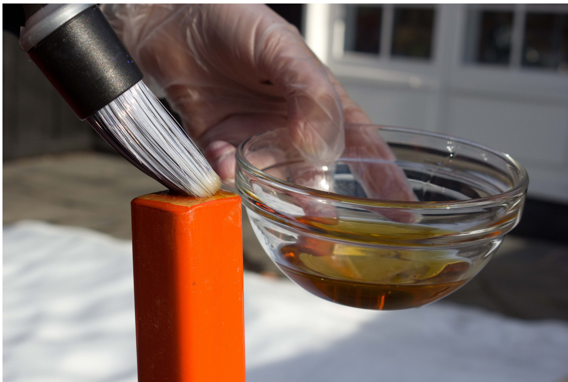
OLJE: Oljen påføres med pensel til treet er mettet.
