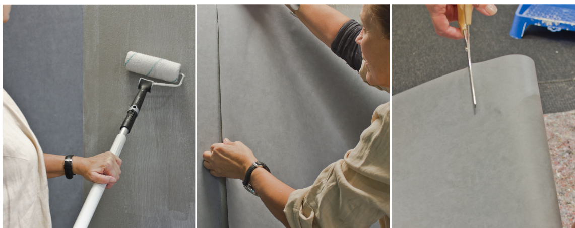
ENKELT: Baksiden er av god fiberkvalitet, noe som gjør den lett å sette opp når limet kan smøres direkte på veggen og tapethøydene ikke skal forfuktes. (Foto: Chera Westman/ifi.no)
