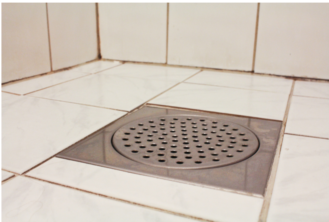
VOND LUKT: Uten jevnlig vask er det ikke uvanlig at det kommer vond lukt fra sluk og avløp. (Foto: Mari Rosenberg/ifi.no)
