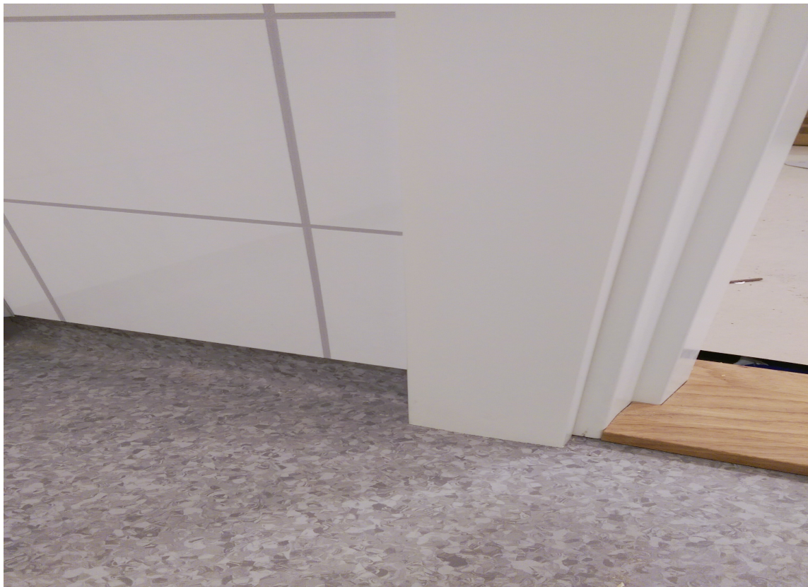
VARIG LØSNING: Listverk i HD polystyren tåler vann og hverken krymper eller sprekker opp. (Foto: Deco Systems)
