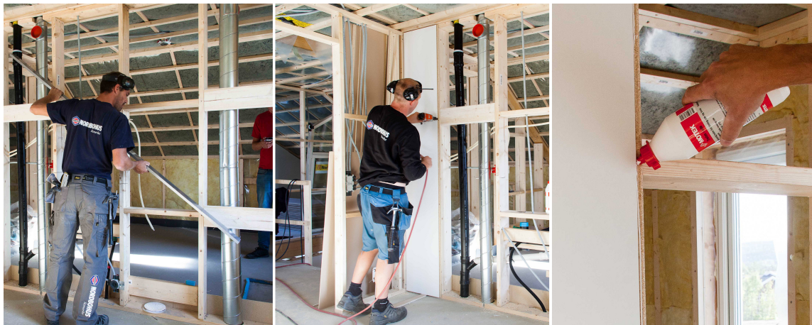
1, 2, 3: 1. Sjekk underlaget med en rettholt, 2. Start monteringen i hjørnet, og 3. Lim og klikk. (Foto: Kristian Owren/ifi.no)
