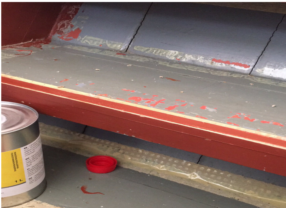
RENE TRINN: Det tar tid å bli kvitt lim- og tepperester i trappen. Men det finnes midler som hjelper. (Foto: Margrethe Sverkmo)
