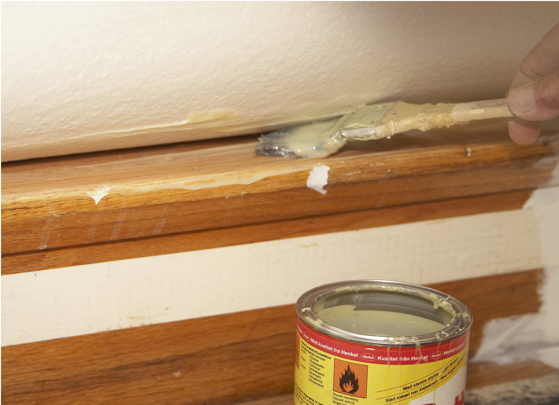
PÅ OG AV: Tepper i trappen limes fast. Når teppet skal bort, må limet fjernes. Da kan du skrape og slippe bort restene. – Det er mest effektivt, sier Thomas Solheim hos Sika Norge. (Foto: Kristian Owren/ifi.no)
