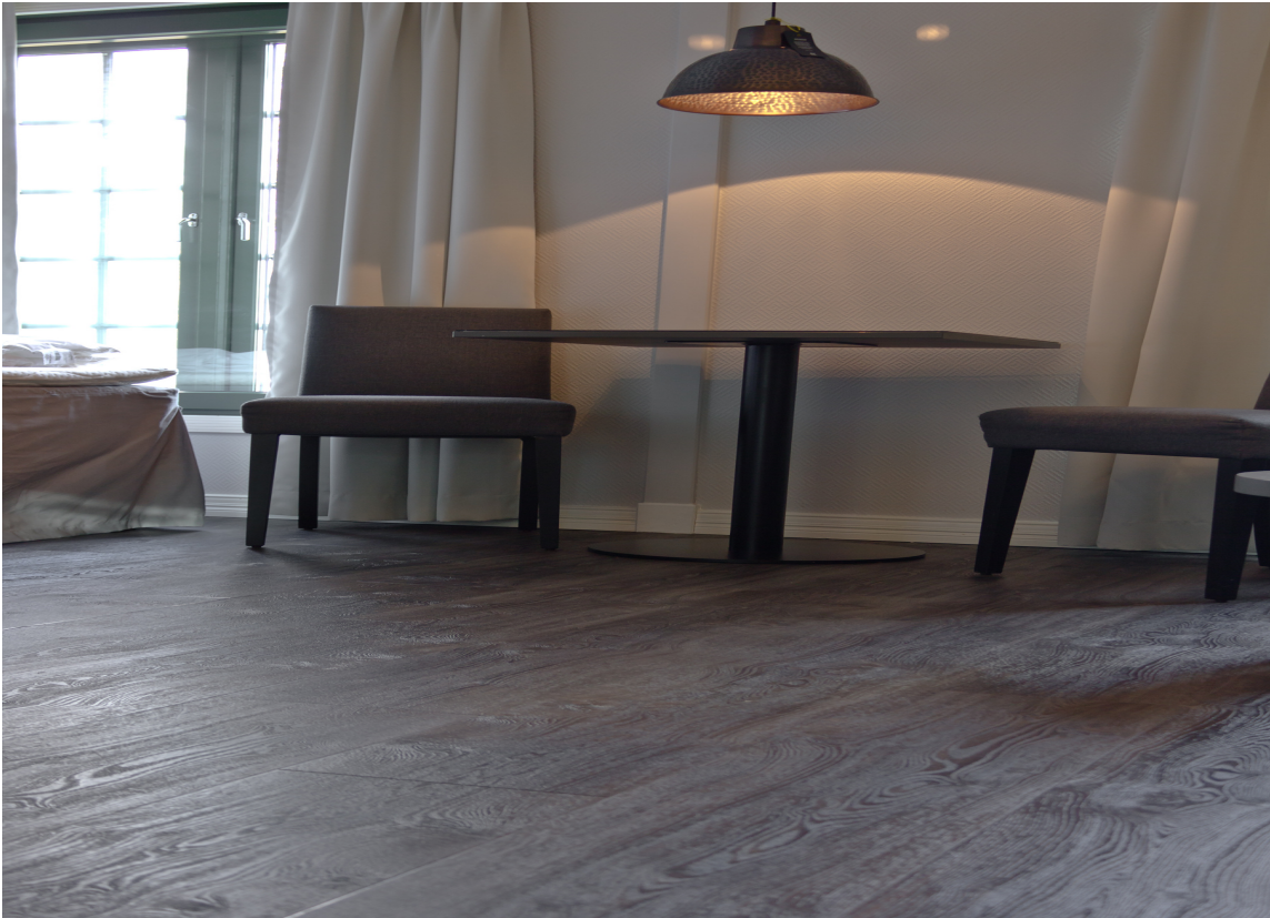
DESIGNGULV/LVT: Ehrenborgs Nordic Flooring ERP 61714-229, en 2,5 millimeter tykk LVT, er lagt i leilighetene. Under designgulvet ligger et akustikkunderlag fra Uzin.
