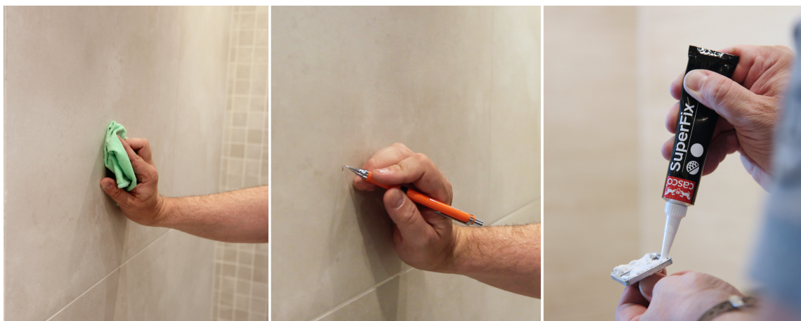
FORARBEID: 1. Rengjør, 2. Planlegg og 3. Påfør lim.
