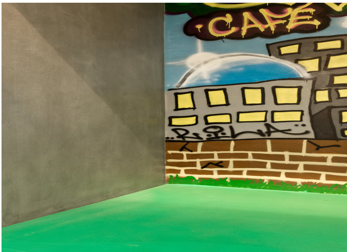
BETONGKULT: Tilstøtende vegg og gulv er behandlet med Beton Cire - et produkt som gir betonglook og som kan farges i nært sagt hvilken farge du ønsker.
