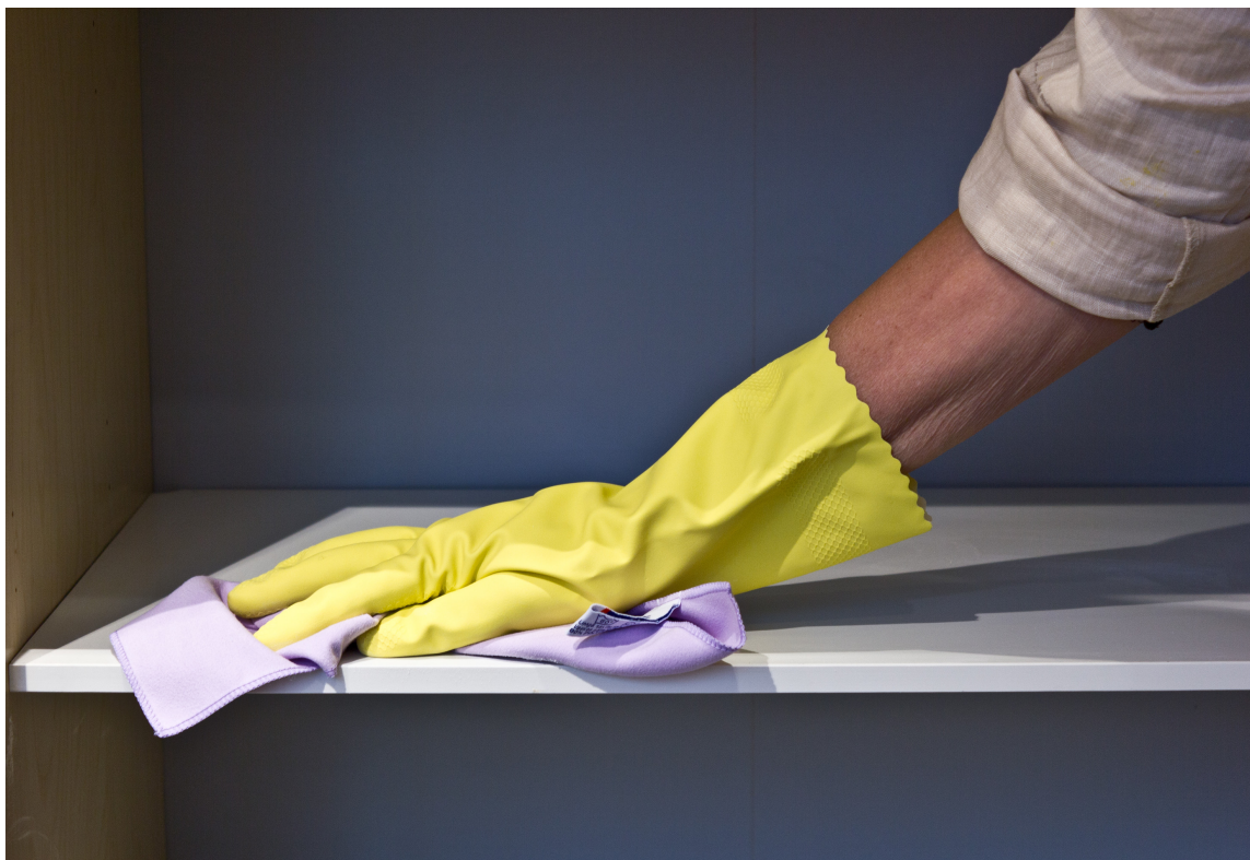
AVSTØV: Bruk en tørr mikrofiberklut til å fjerne slipestøvet. (Foto: Mari Rosenberg/ifi.no)
