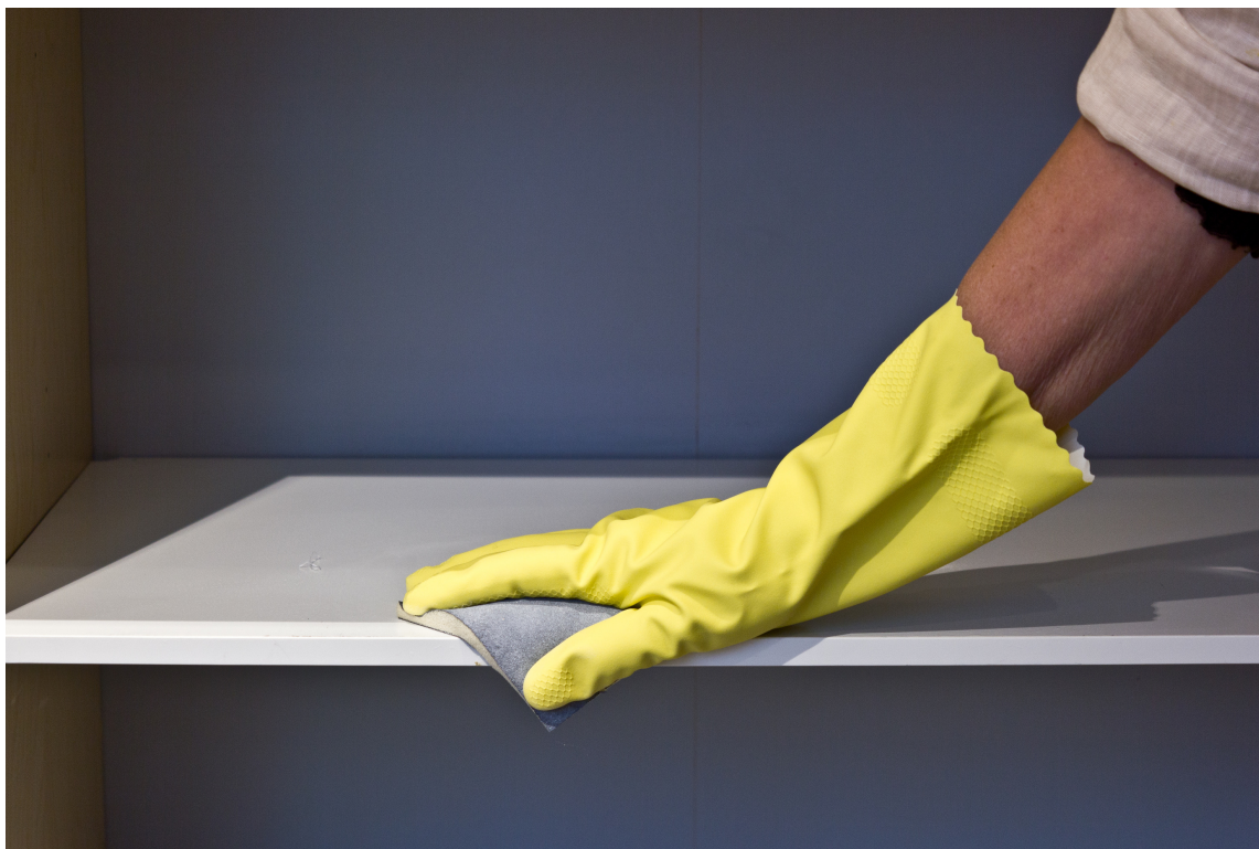
SLIP: Mattslip flatene med en slipepad for god vedheft. (Foto: Mari Rosenberg/ifi.no)
