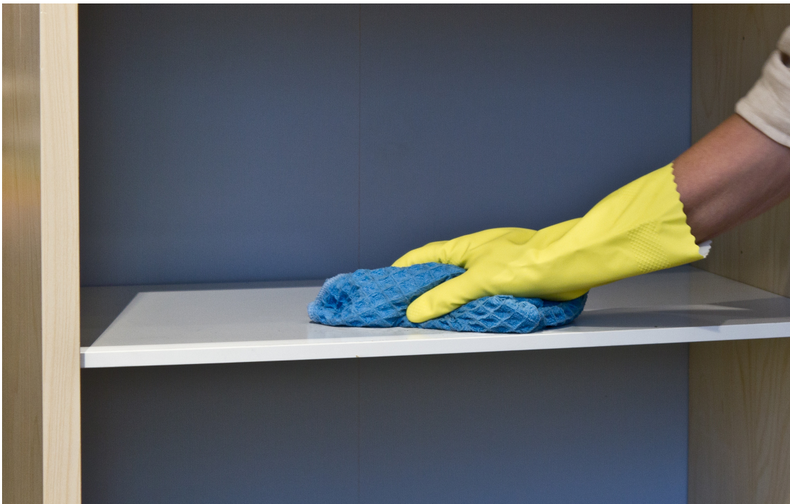
FORARBEID: Rengjør med et rengjøringsmiddel beregnet for bruk før maling. (Foto: Mari Rosenberg/ifi.no)
