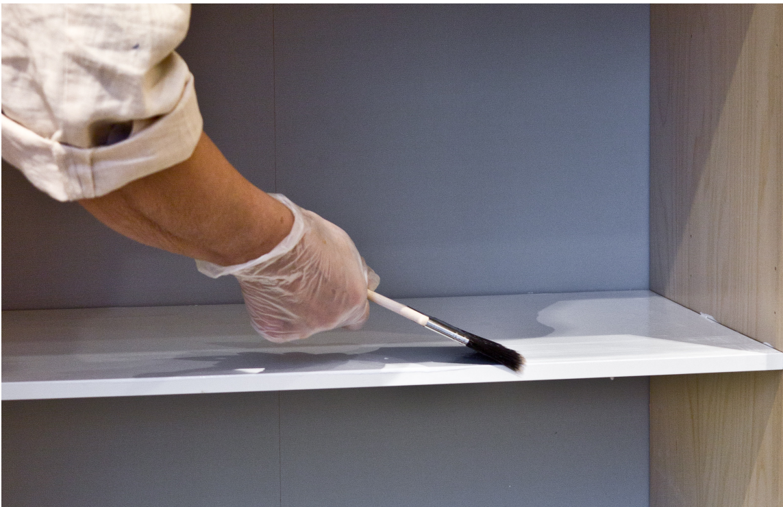
STRYK: Bruk en fordriver for å fjerne rullestrukturen. (Foto: Mari Rosenberg/ifi.no)
