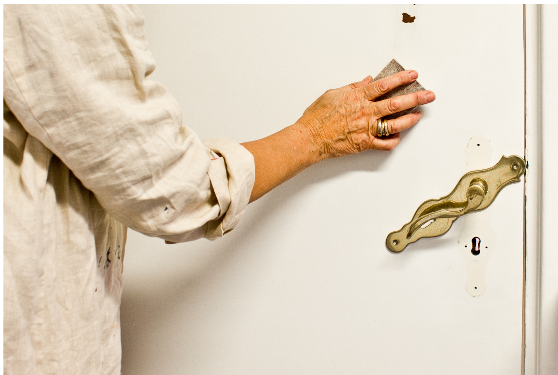
FORARBEID: Forarbeidet er like viktig som selve malingen. Mattslip for god vedheft. (Foto: Mari Rosenberg/ifi.no)
