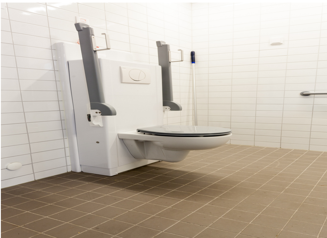
DELIKATE BAD: Nye Gullhella bo- og aktivitetssenter er fordelt over tre etasjer. Hvert av de 60 rommene har store og delikate bad med tilpassede toaletter. Flisene på gulvet er lette å holde rene.
