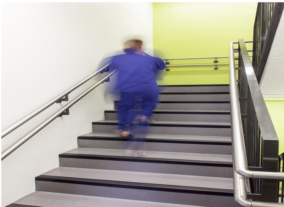
TRIPP TRAPP: Trappegangene i det nye omsorgssenteret preges av friske farger og solide trapper med gummibelegg fra Nora Systems. De har levert gummigulv til Asker kommunes flaggskip innen omsorgsboliger.
