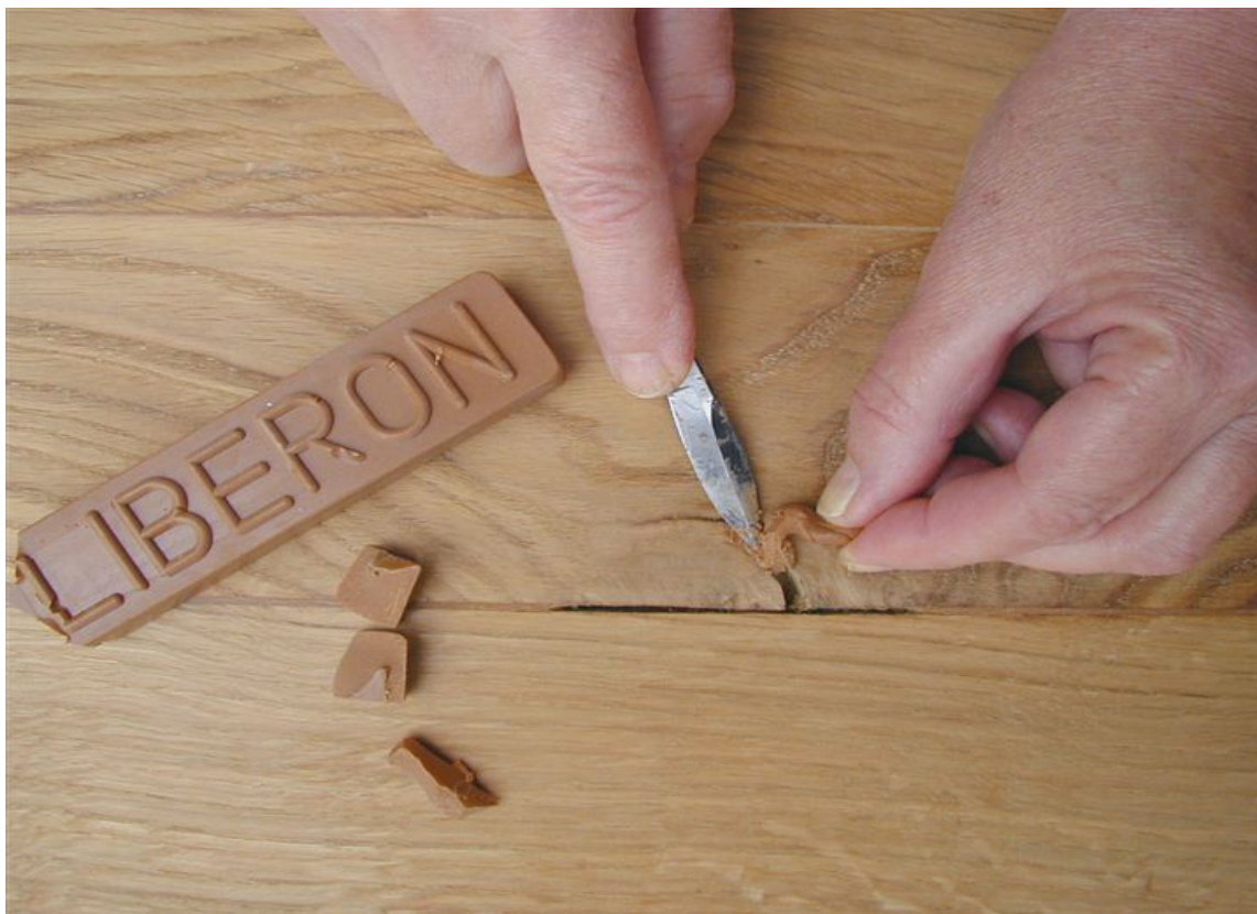
SMÅSKADER: Små sprekker og spikerhull kan repareres med Liberon reparasjonsvoks.
