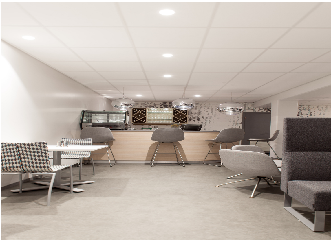
LØSTLAGT: Det lyst grå gulvet er et løstlagt vinylbelegg fra Tarkett, av typen Acczent Unik 80 i fargen Concrete/Dark grey.
