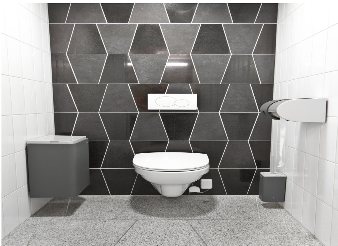
VEGGMONTERT: Toalettene på senteret et utstyrt med Geberits vegghengte klosetter med Duofix Sigmasisterner der sisternene er bygget inn i vegg og betjenes med Sigma 01 hvit betjeningsplate.
