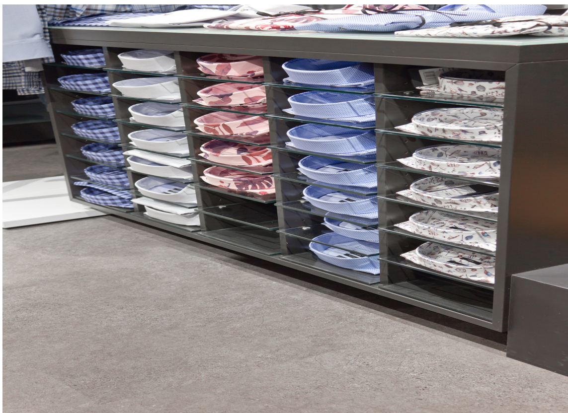
BETONGLOOK: I den nåværende Match-butikken ligger det 609,6 mm x 609,6 mm store betonglignende LVT-fliser fra kolleksjonen Polyflor Expona Commercial.
