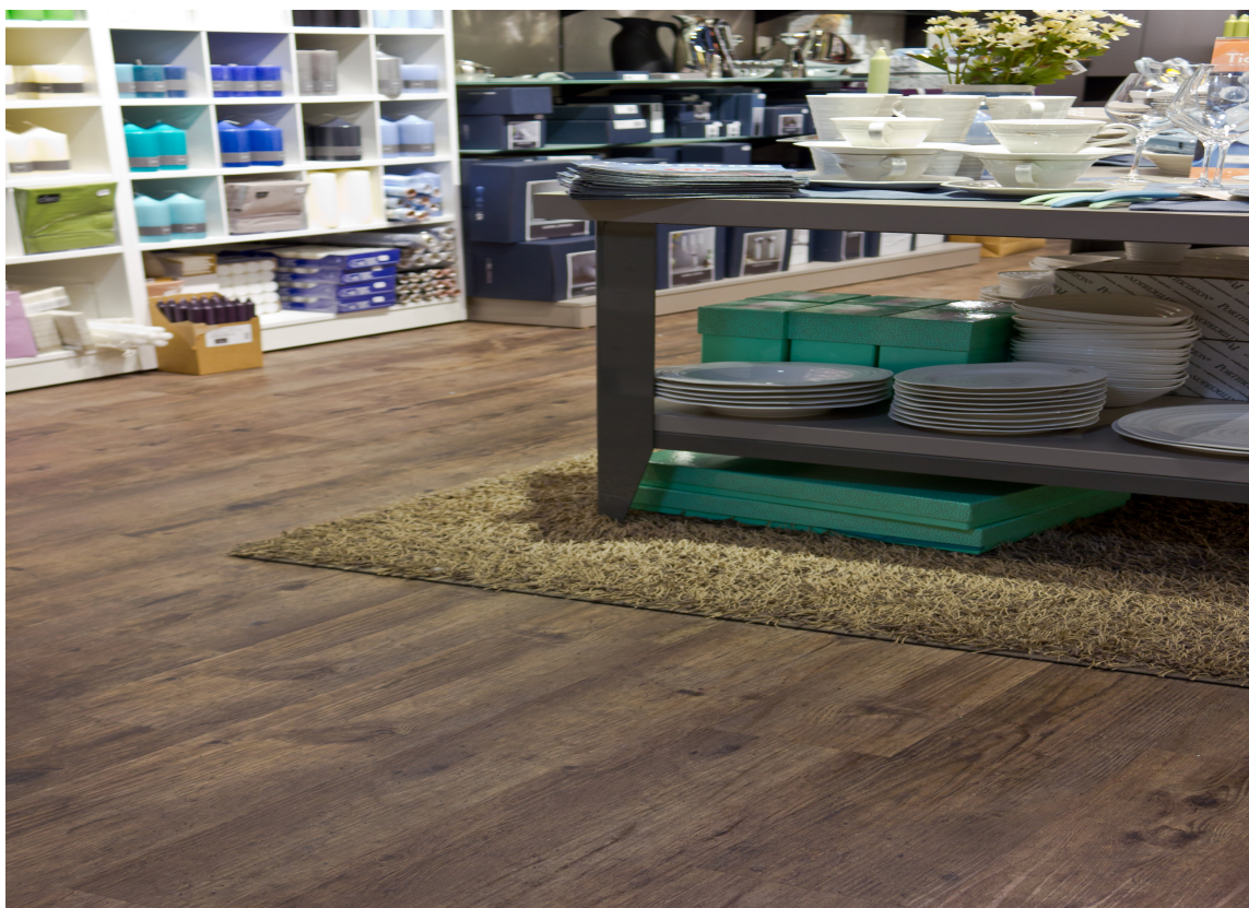
TILBORDS: Kjeden har siden 1976 solgt kjøkkenartikler og interiørprodukter. Butikken på Fornebu S er innredet med et LVT-gulv i 2,5 mm tykkelse som minner om værslitt eikplank (4019 Weathered Country Plank).
