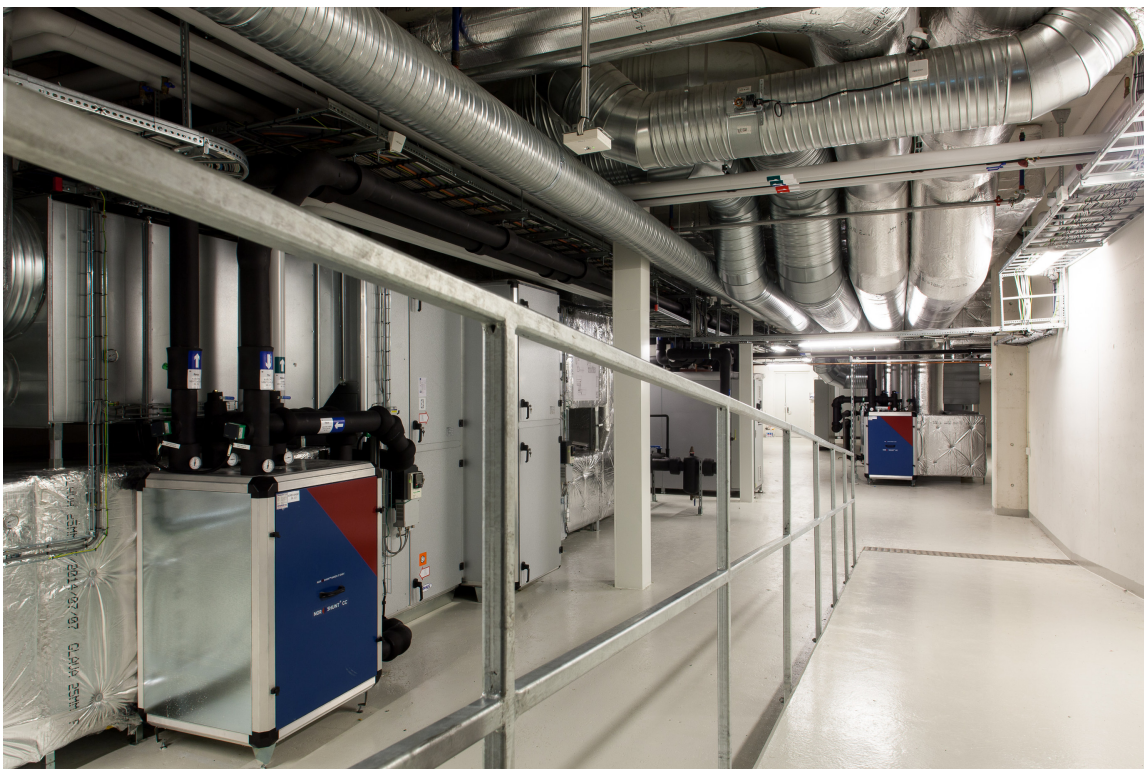
FREMTIDEN: Skolen er et «Future built»-bygg. Det betyr strenge krav til tekniske anlegg, materialbruk og dokumentasjon.
