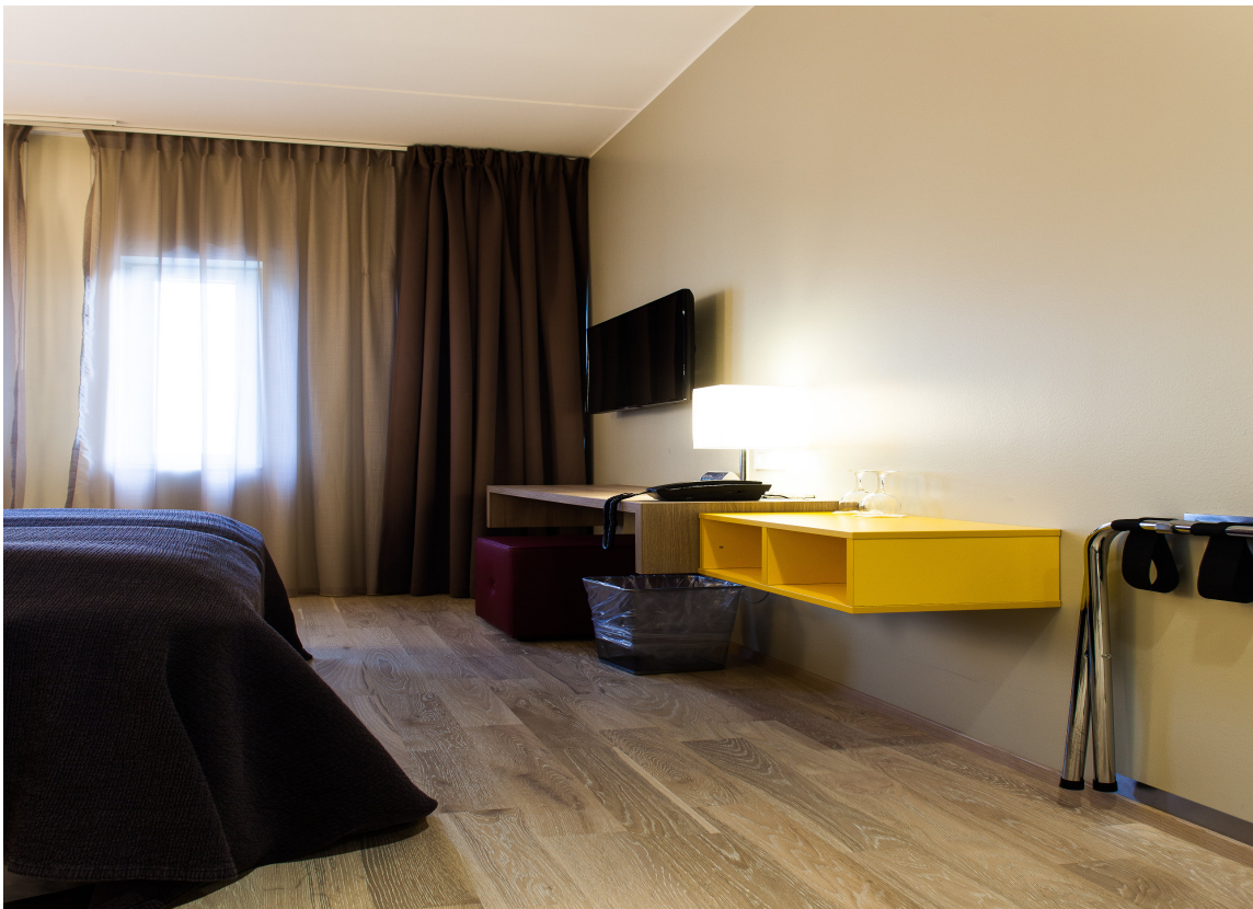
TRINNLYD: Tre- og laminatgolv montert flytende på et akustikkunderlag gir gode trinnlydsegenskaper, men den harde overflaten gir elendige trommelydegenskaper. Foto: Kristian Owren/ifi.no
