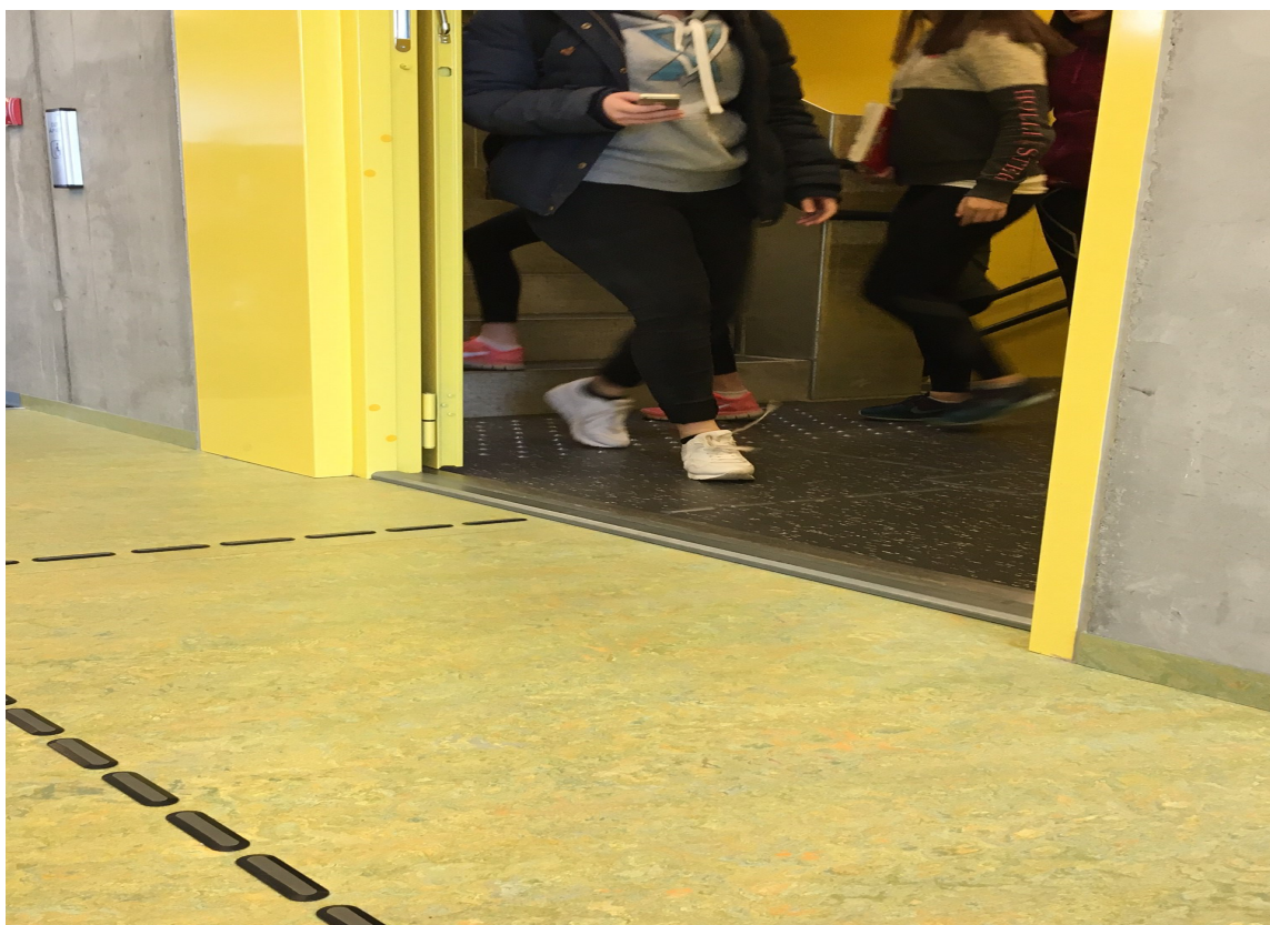
FARGENE VISER VEI: Surrønn linoleum i en allmenning møter trappeløpet med sortmelert belegg. Fargene forteller veien.
