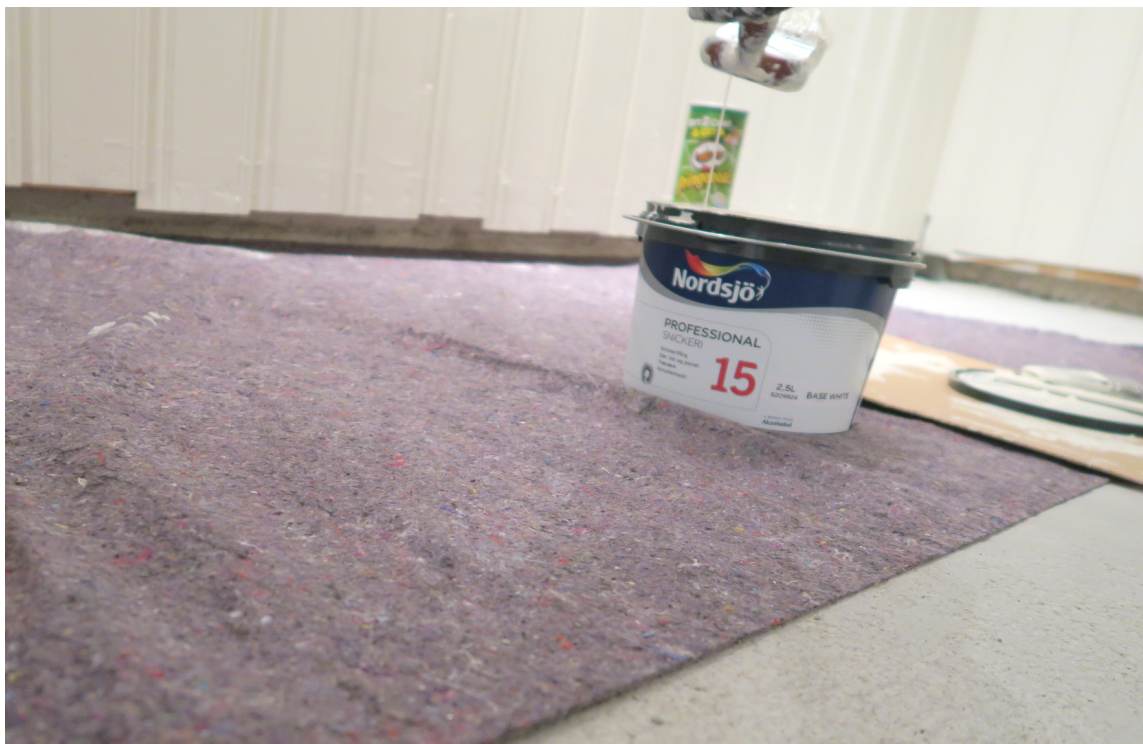
FILT PÅ GULVET: Malerfilt er malerens beste venn mot søl. Filten kan legges på alle underlag.
