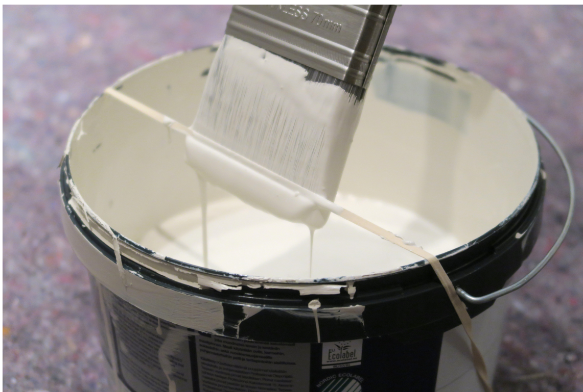
STREKK STRIKKEN: En strikk rundt malerspannet gjør det enkelt å tørke av penselen når du maler.
