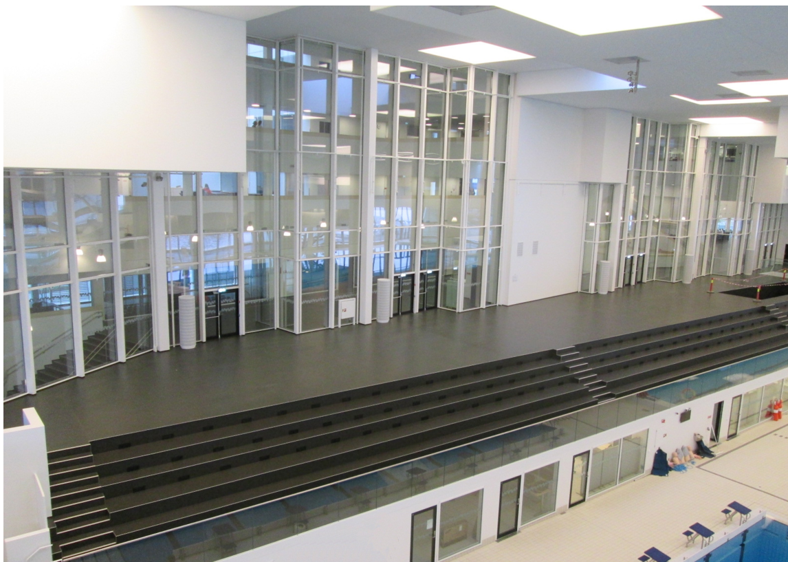
HYGIENE: Svømmeanlegget er direkte knyttet til skolebygningen, og synlig gjennom den høye glassveggen. Det er lagt DLW linoleum på tribunen og i de tørre sonene. Gulvet har en bakteriehemmende effekt på grunn av sine naturlige komponenter som brems
