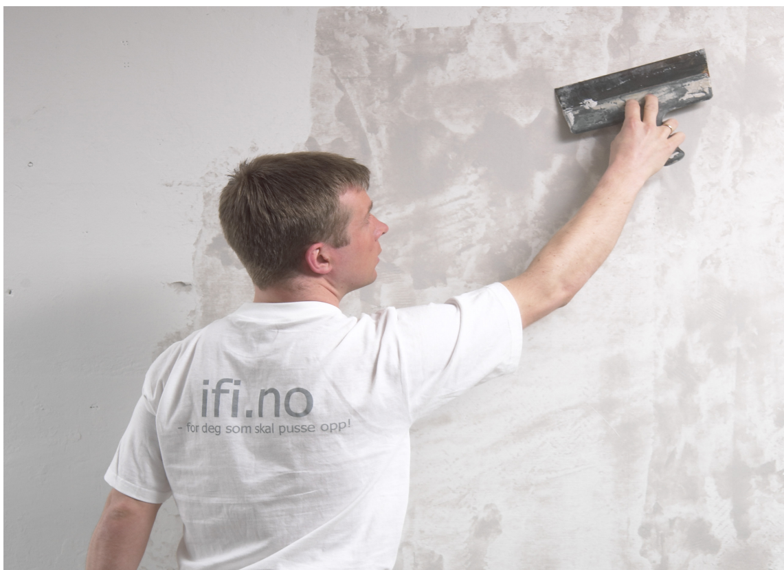
Ved håndsparkling legges sparkelmassen på med en bred sparkel og trekkes av med en litt smalere.
