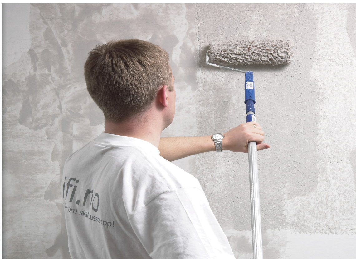
Rullesparkel påføres med rull og slettes med en bred sparkel. Veggens må sparkles i flere omganger og slipes mellom hvert lag.
