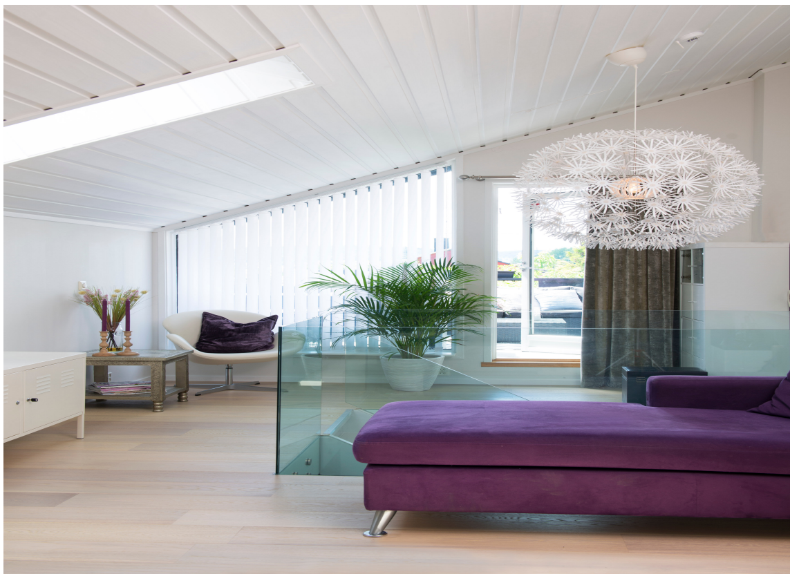
Her er det gamle «sprosserekkverket» i furu erstattet med glass.
