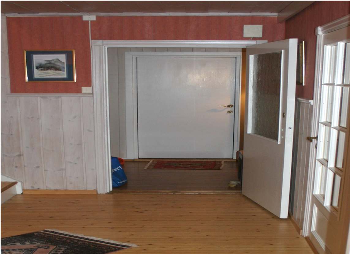
Inngangspartiet var oppdelt og trangt.
