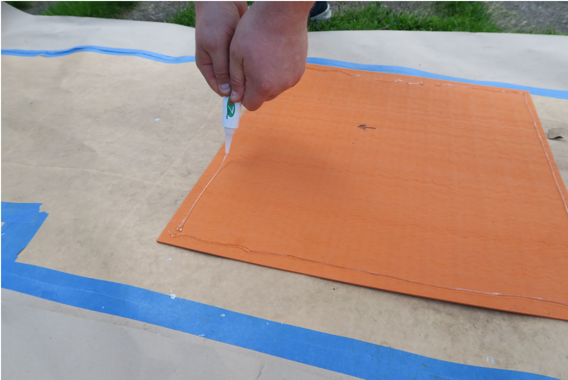
Vi påfører lim langs kantene og på kryss og tvers.
