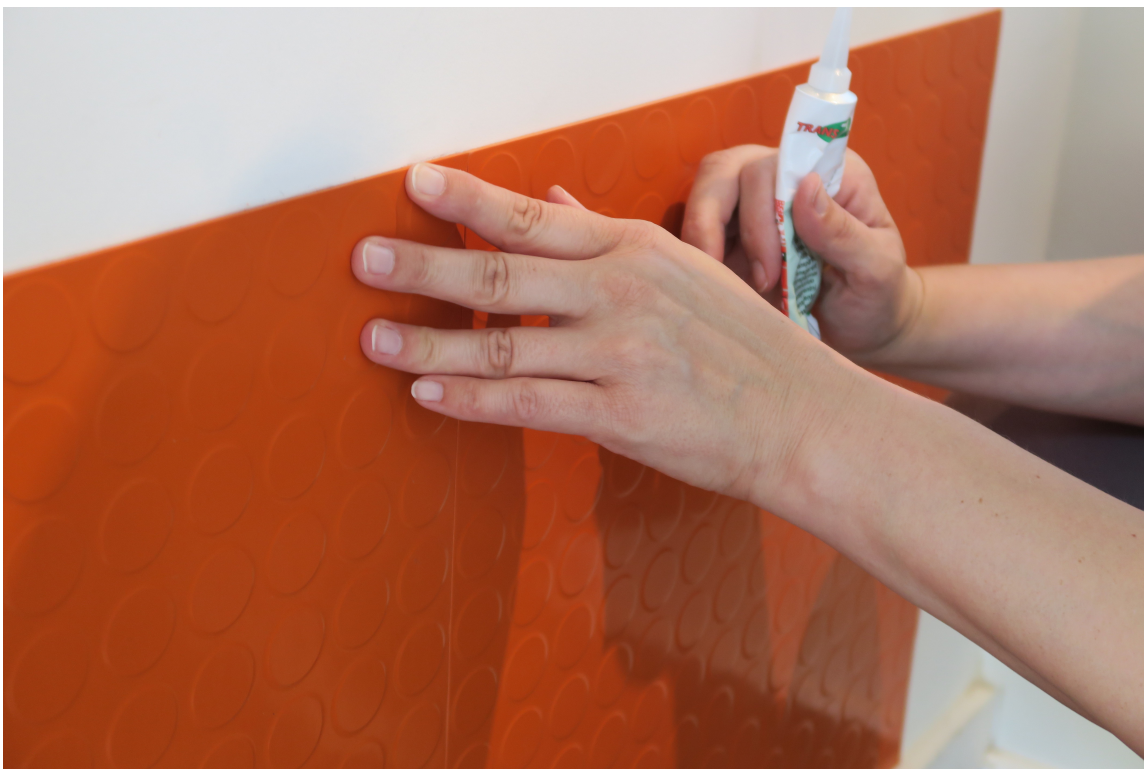
Våre fliser fikk egnet lim på baksiden og festet seg enkelt mot veggen.
