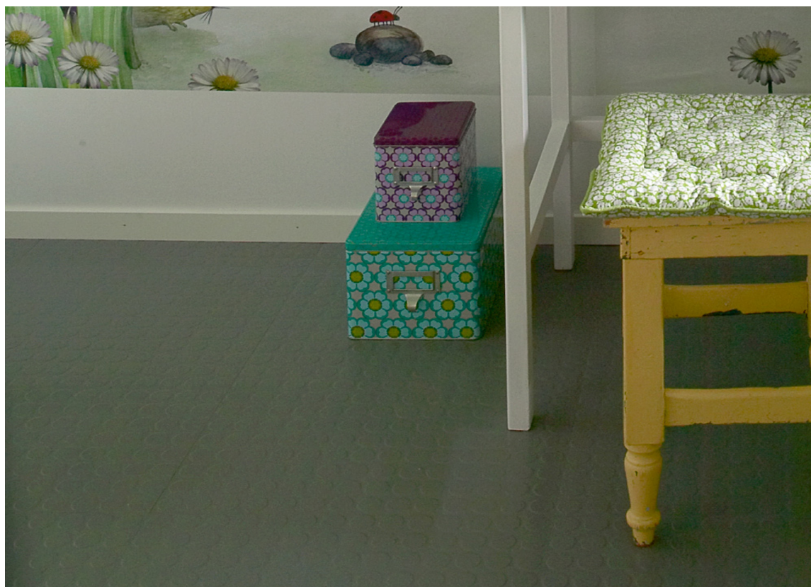
Et tøft, komfortabelt gummigulv erstattet nålefilten.
