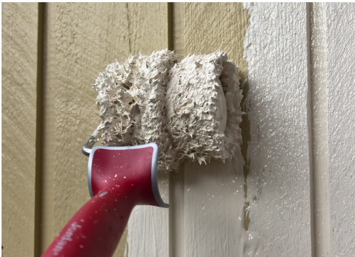
Maling påføres raskest og jevnest med rull, og glattes ut med en flat pensel. (Foto: Chera Westman/ifi.no)
