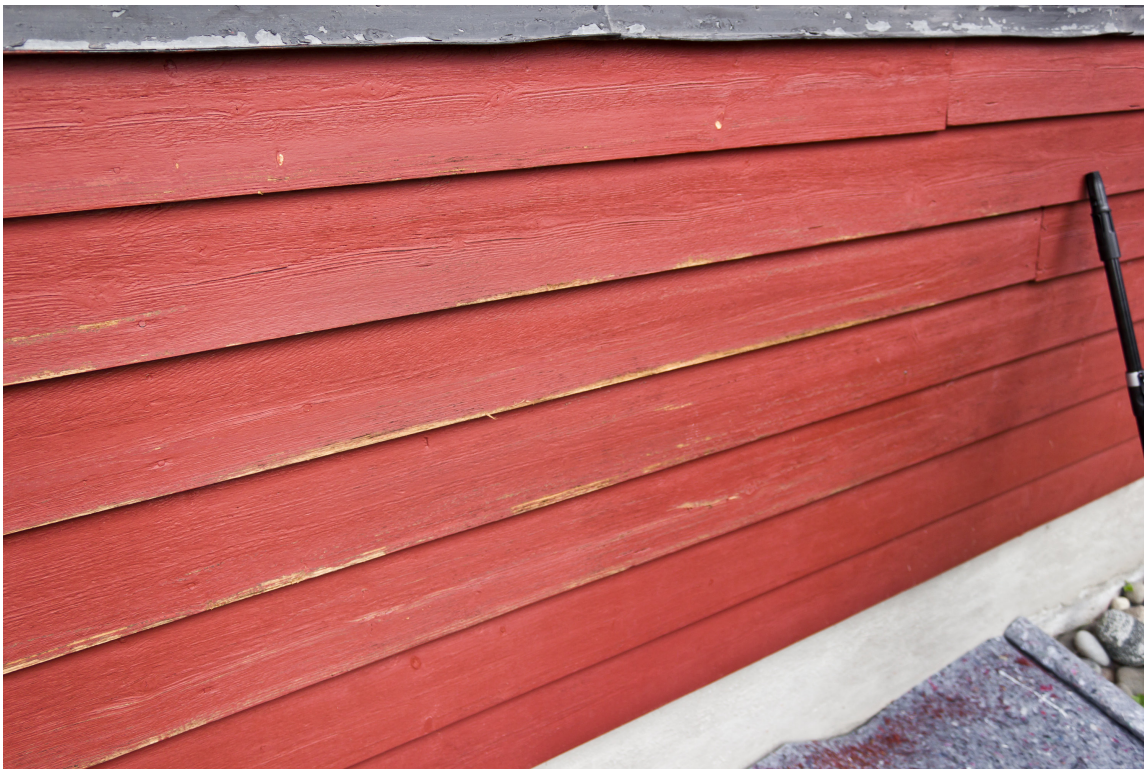
Bart treverk skal grunnes.
