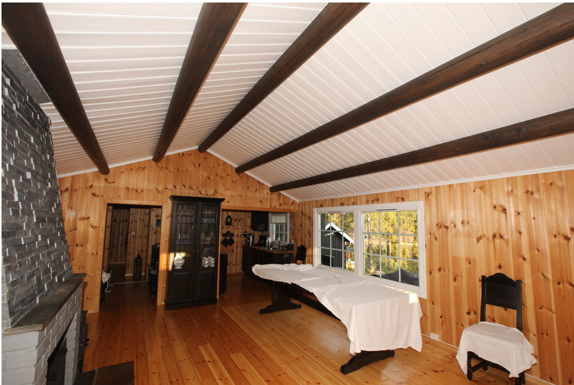
Mellom hvert panelbord ble det fuget med akryl. – Toppstrøket ble malt med Nordsjö Professional dør/list-panel 15 i farge S-0502Y, forteller Enrico Bastiani hos Nordsjö.
