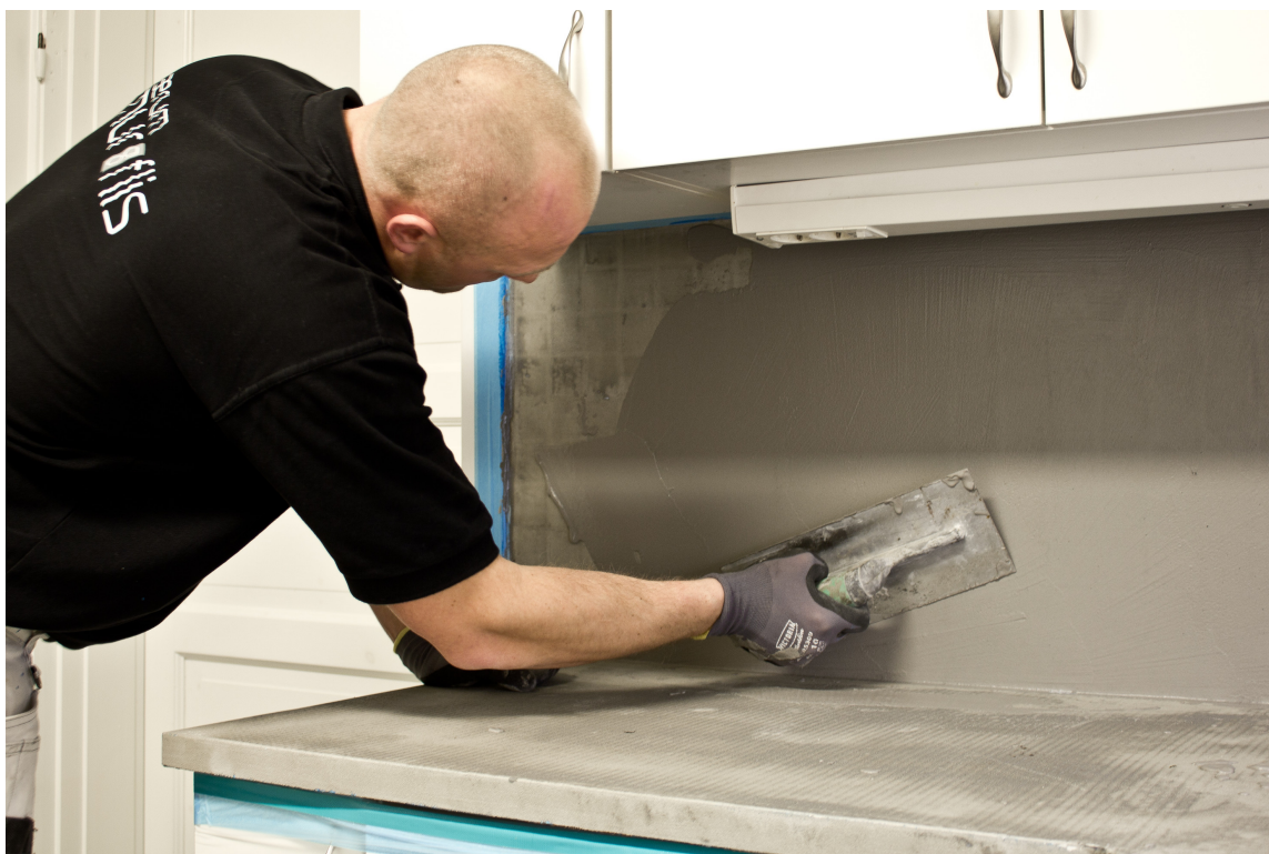
Beton Cire kan brukes for å gi de aller fleste underlag en tøff betonglook.
