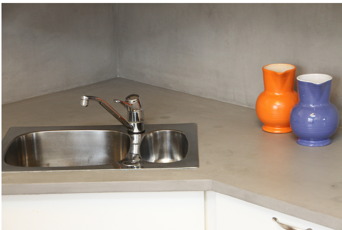
Benkeplaten på dette kjøkkenet var en gang en laminert sponplate. Den fikk etter hvert fuktskader og begynte å svulle. Vi freste bort skadene og valgte å gi den nytt liv med betongpulver, før vi forsegllet med PU-lakk. Resultatet ble røft og stilrent.
