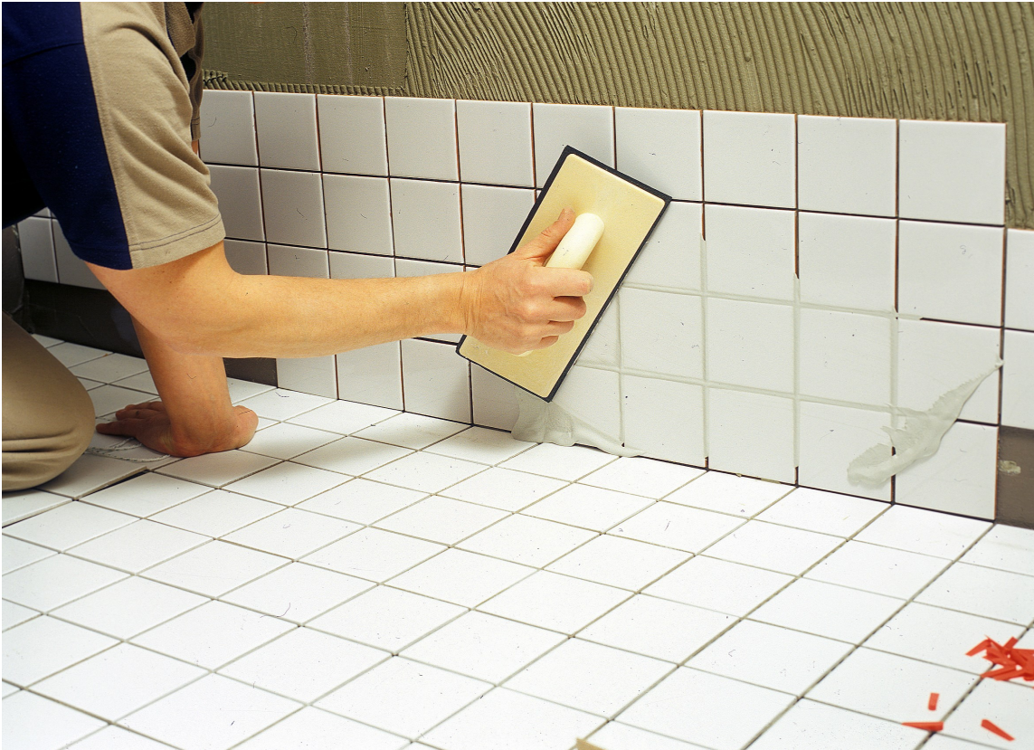
Pågående arbeid: Slik legger du fliser på et bad.
