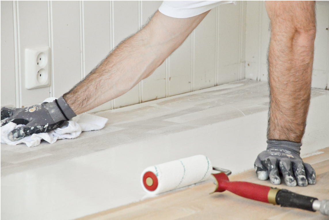
Det nyslipte gulvet ble farget med hvitpigmentert olje. Etterpå ble det lakkert med matt gulvlakk.
