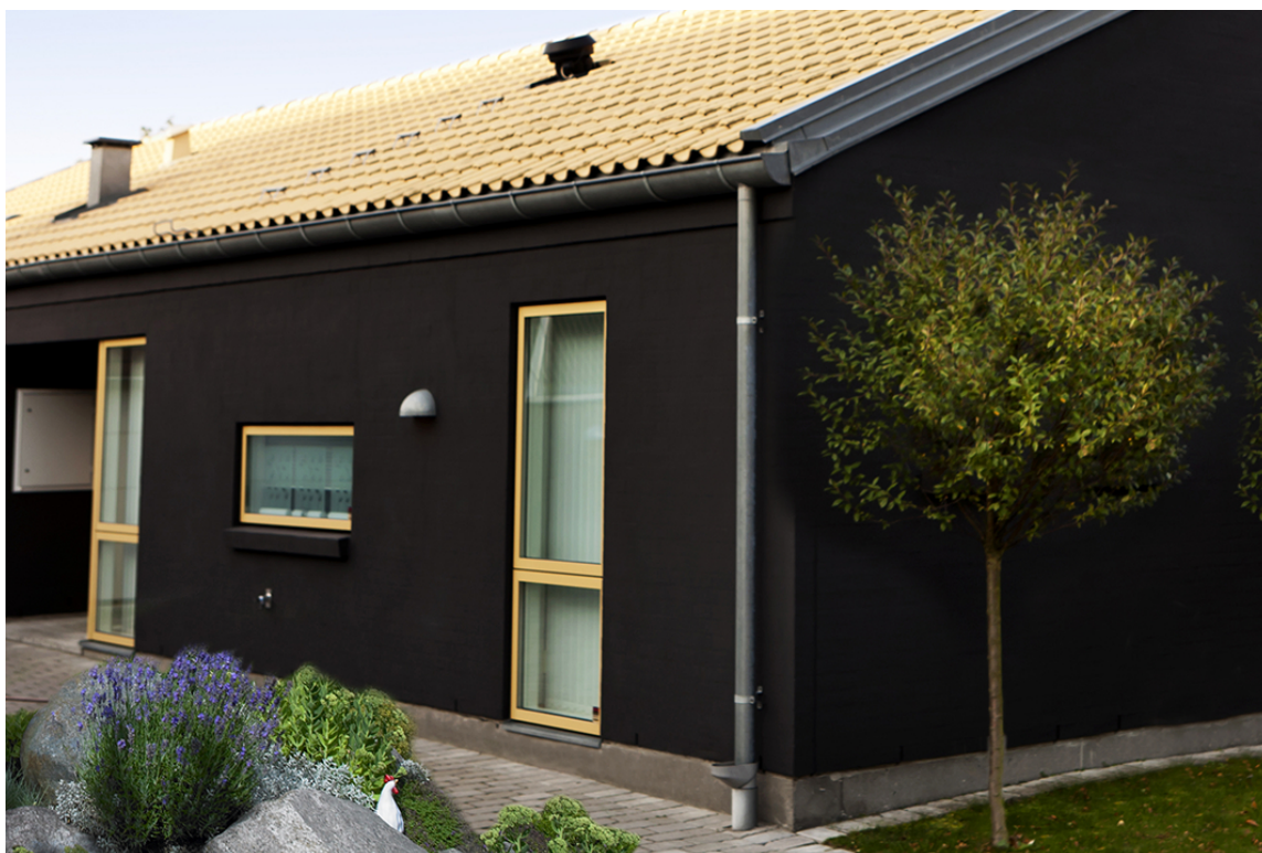
Ta en runde og sjekk nedløpsrør og hengerenner. Foto: Nordsjö
