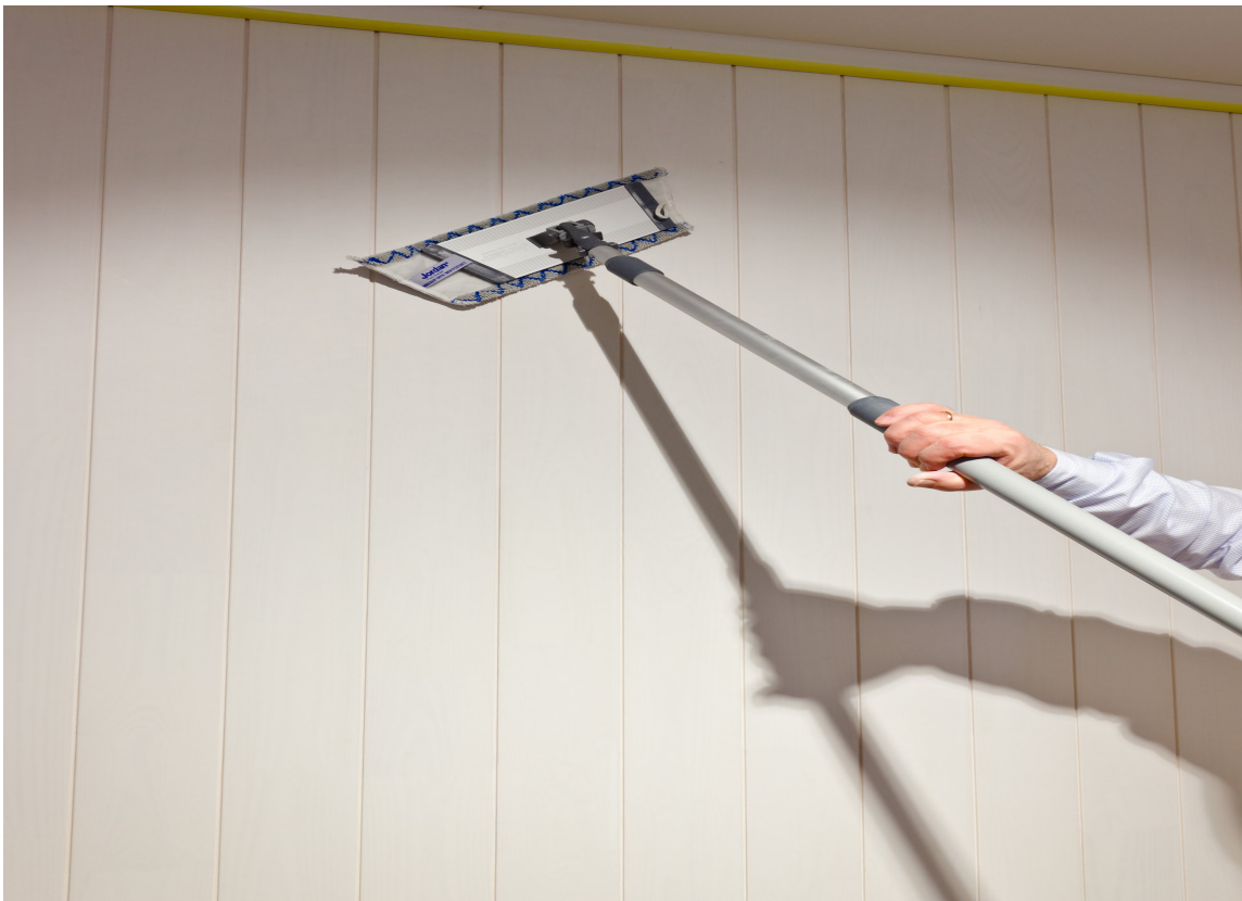
Fjern støv med en mikrofibermopp.
