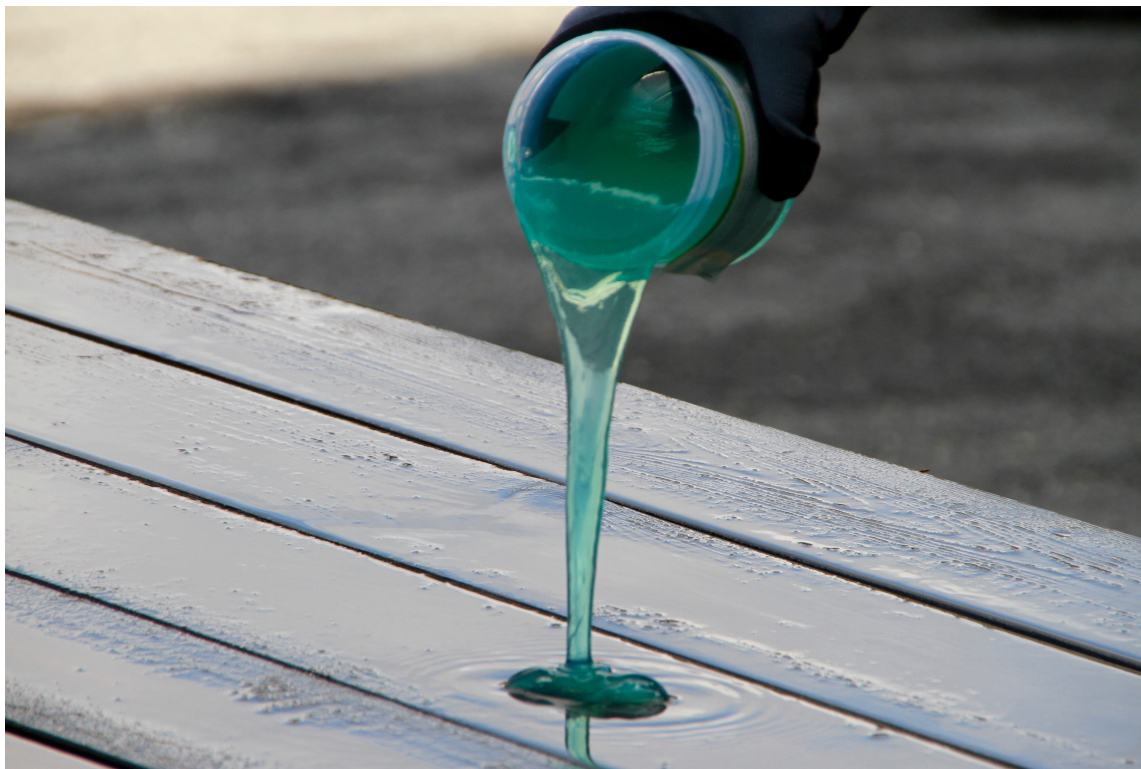
Hell gele på terrassen og fordel et tynt lag utover.
