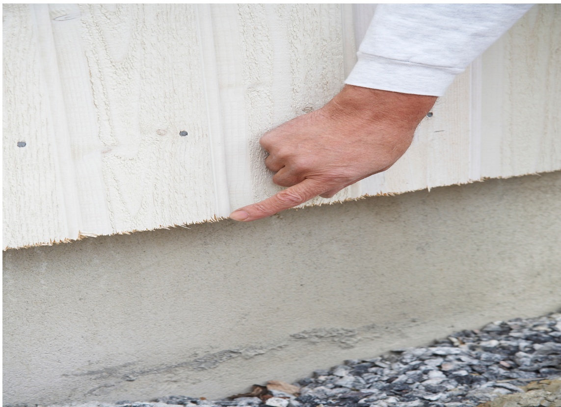
Alle kuttflater og spikerhull må grunnes ved montering.
