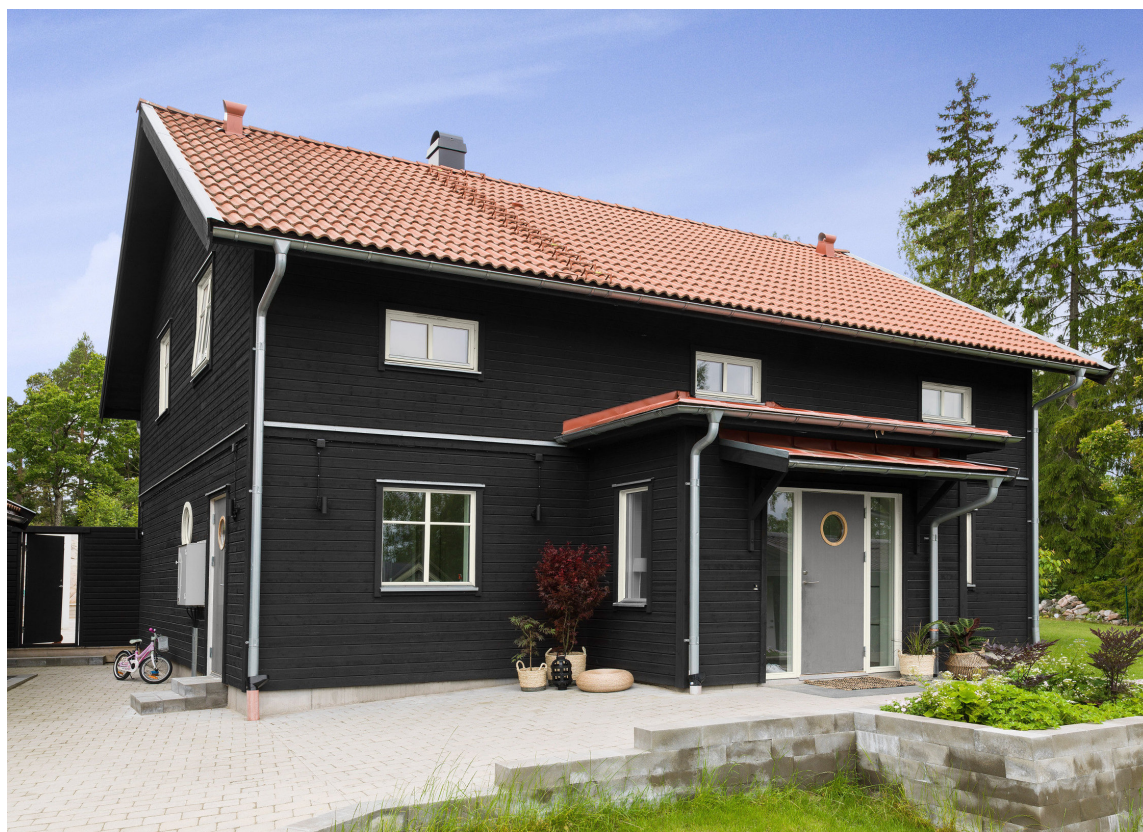
HELHET: Tak og takrenner er også en del av den totale fargepaletten.
