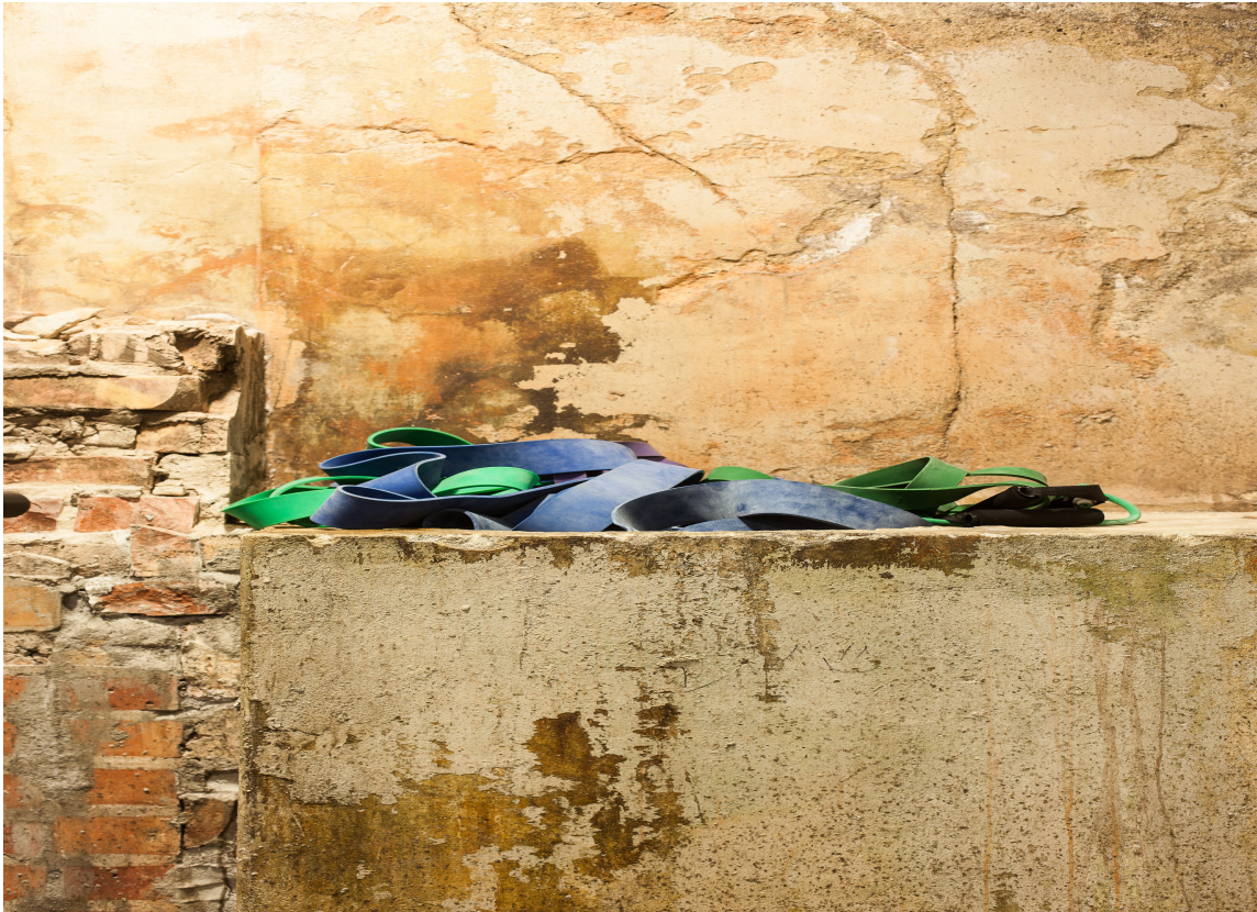
Historisk preg: I kjelleren bærer veggene preg av 100 års historie. Murveggene er bevart, og kun støvbundet med en panellakk fra Nordsjö i ettertid. Dette gir rommet et autentisk og rustikt uttrykk.
