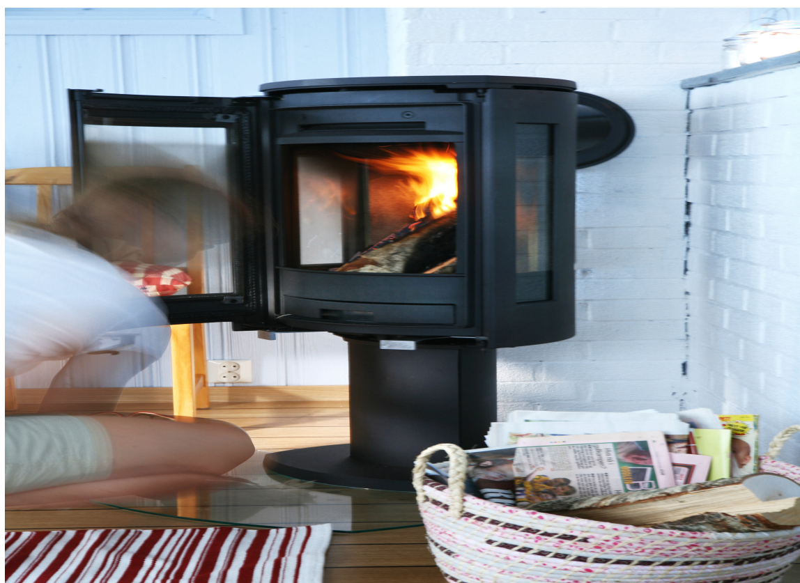
Ny ovn i fornyede omgivelser; hvitmalt brannmur og svale, blå vegger. De nå synlige flammene bidrar godt til atmosfæren.
