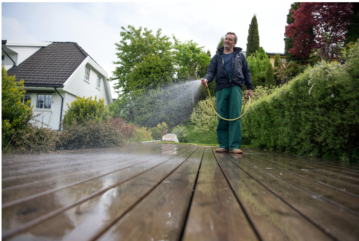
Til terrasserengjøring brukes sterke såper som må skylles grundig vekk før ny beis påføres. Foto: Jordan
